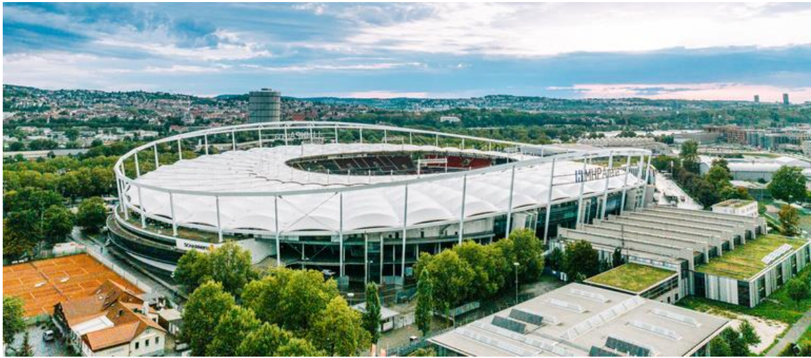
Figure 12: Le Stade du VfB et son nouveau Namer depuis l'été 2023, MHP 19
