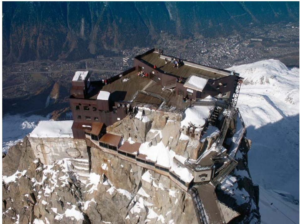
Pl. 13 Aiguille du Midi. Vue depuis le pilier central du pilier nord et de la vallée de Chamonix (photo. J.-P. Pralong, novembre 2003).
