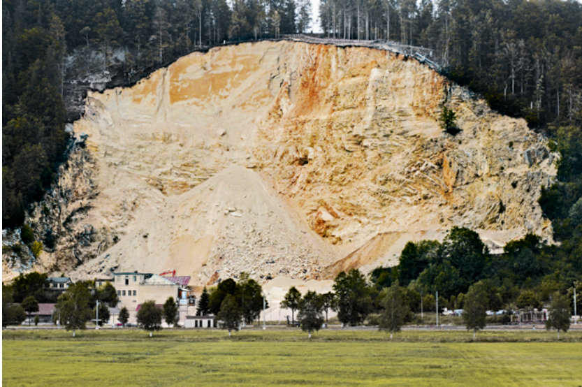
Fig. 45: Vue du front d'exploitation de la carrière des Granges au Col des Roches («carrière Brechbühler»). La pente structurale visible en haut à gauche correspond à la surface de rupture de l'éboulement de 2017 qui a formé l'imposant cône visible au pied de la paroi. On distingue sur la droite une série de chevauchements subhorizontaux menant à la formation d'écailles dans le flanc redressé et la charnière du coffrage de l'anticlinal de Pouillerel. Photo U. Eichenberger, 2018.
