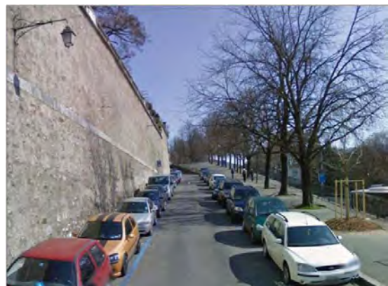
Figure 18: Rampe de la Treille
