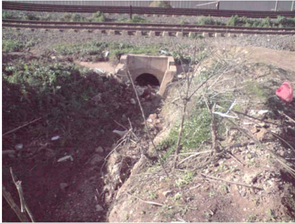
Photo 7. Buse insuffisante pour l'évacuation des eaux au passage de la voie de chemin de fer
