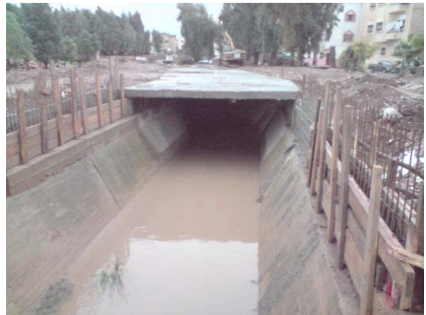
Photo 4. Canal couvert de l' oued El Mehraz dans le quartier Montfleurie
