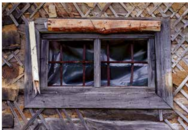
Fig. 7. Protection plastique installée à une fenêtre de l'isolateur disciplinaire (B3). En 2020, les plastiques ont été remplacés par des vitres.
