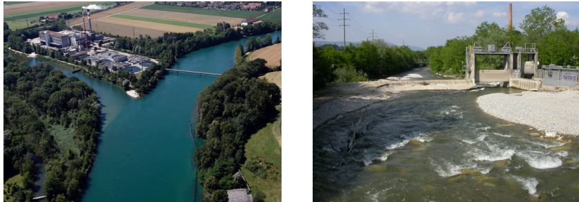
Fig. 7.1 : La confluence de l'Emme et de l'Aar au niveau de l'Emmenspitz (à g.) et le barrage à hauteur de Biberist (à d.) Photos : Alpiq, 2016.
