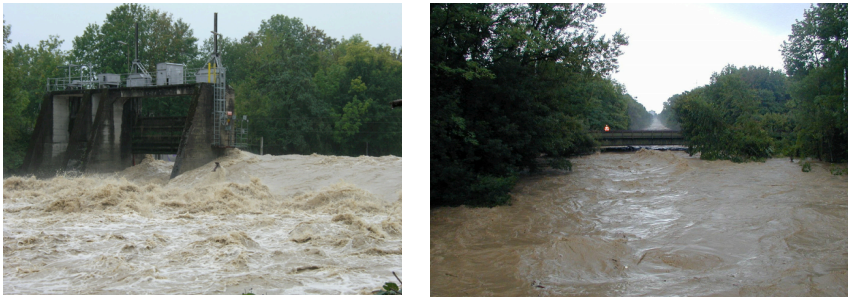
Fig. 7.3 : Les crues de 2007 à la hauteur du barrage de Biberist (à g.) et à proximité de Derendingen (à d.). Photos : SRF, 2007.
