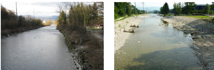
Fig. 7.5 : L'Emme avant (à g.) et après (à d.) le réaménagement sur le premier tronçon du projet. Photos : Hunziker, Zarn & Partner, 2016.
