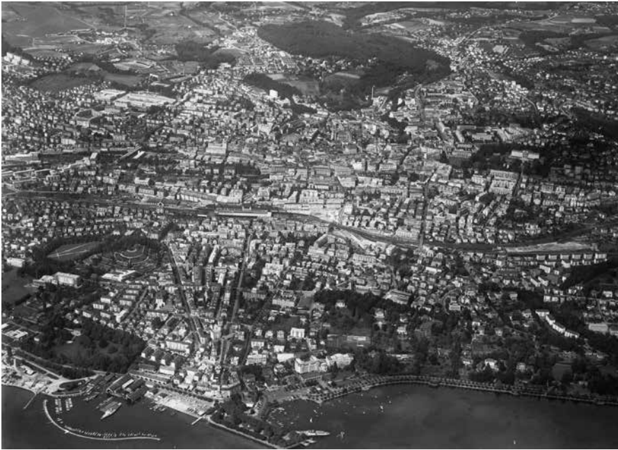
Fig. 2: L'urbanisation croissante des rives du Léman amène à l'étude des premières stations d'épuration des eaux dans les années d'après-guerre. La Ville de Lausanne lance des travaux préliminaires en 1948 mais n'inaugurera la station de Vidy qu'en 1968. Source: ETH-Bibliothek Zürich, Bildarchiv, Werner Friedli, 1960 / LBS_H1-022615.
