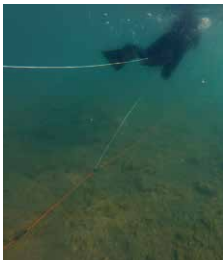
Ρημούλκηση καλωδίου στον θαλάσσιο βυθό. Cable hauling on the seabed.
