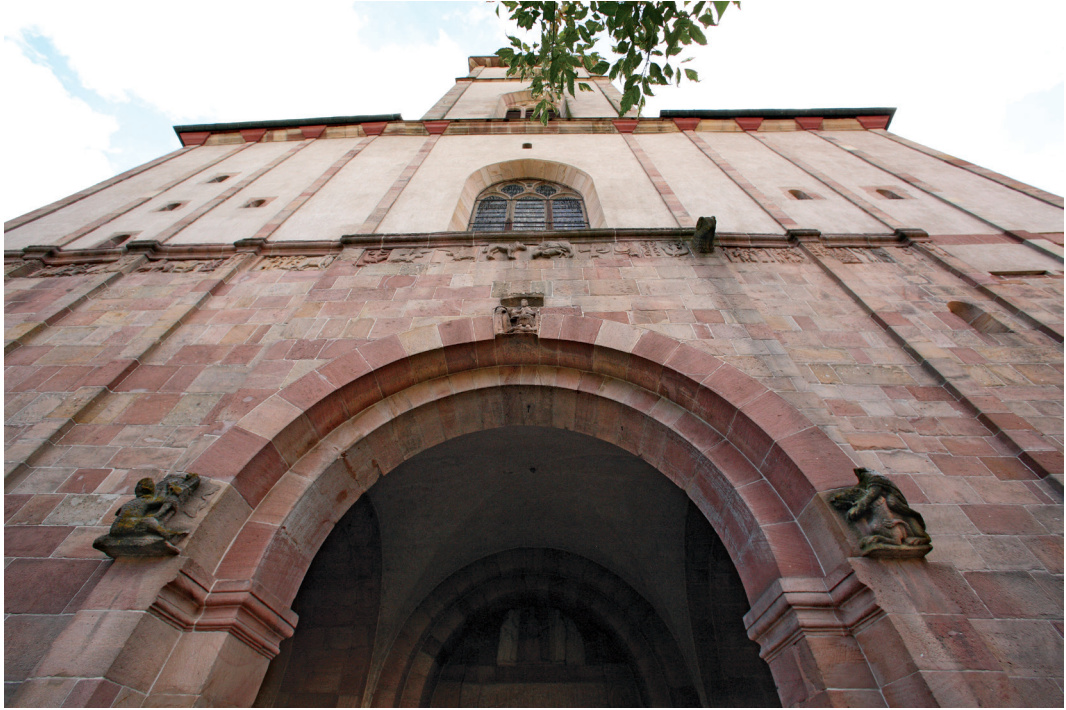
Fig. 14 : Église d'Andlau (Alsace), arc d'entrée de la tour-porche. Cl. R. Hammann.
