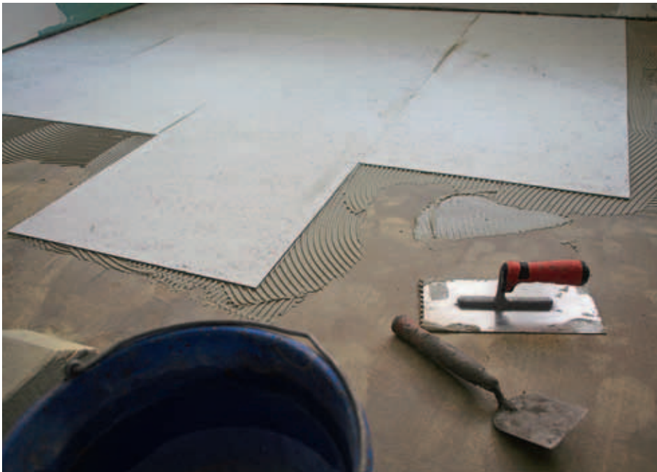
Bei Neubauten oder Sanierungen sollte das Thema Radon besprochen werden.
