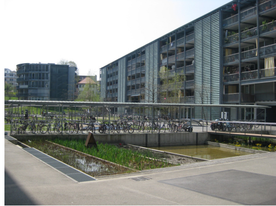
Abb. A4.22: Genossenschaftswohnungen Regina-Kägi-Hof: überdachte Radständer in mehreren Reihen; unfunktionelle heruntergekommene Teichanlage (2010) Quelle: eigene Darstellung
