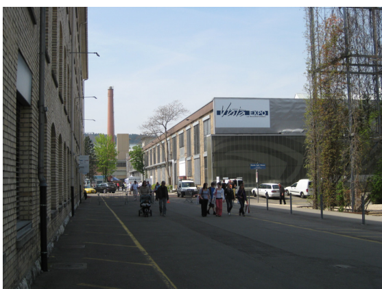
Abb. A4.19: Eventhalle „Event 550“ im umgenutzten Fabrikgebäude am MFO-Park (2010) Quelle: eigene Darstellung
