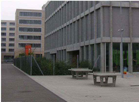
Abb. A4.15: Kindertagesstätte der Schulanlage Im Birch: Gebäude und hoher Maschendrahtzaun ähneln einem Hochsicherheits- trakt (2006) Quelle: eigene Darstellung
