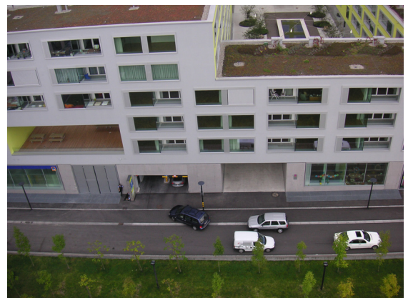
Abb. A4.8: Oerliker Park (Südrand): Durchgehender Verkehrsstrom zur Discoutertiefgarage trennt Kindertagesstätte von Grünfläche (2006) Quelle: eigene Darstellung
