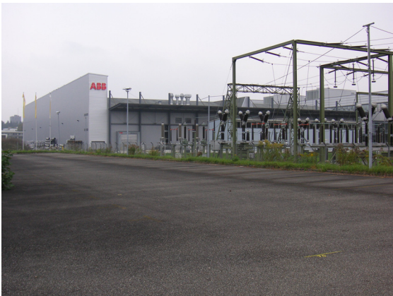
Abb. A4.23: ABB Schaltanlage, noch in Betrieb (2006) Quelle: eigene Darstellung
