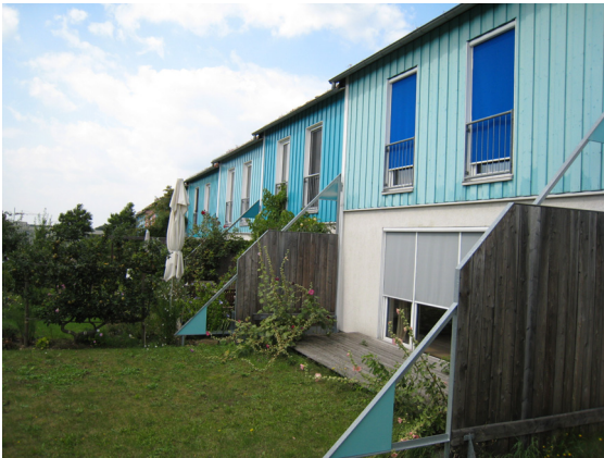
Abb. A3.28: Koordinierte Reihenhausprojekte der ersten Generation: kleinflächige Wohnfläche, Grasdächer, Gemeinschaftsgedanke, durchlässige Vegetation anstatt von Zäunen und Hecken (2007) Quelle: eigene Darstellung
