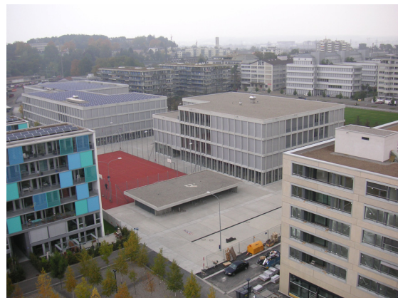
Abb. A4.14: Schulanlage Im Birch; im Hintergrund Grasfläche vom Wahlenpark mit angrenzender Wohnbebauung außerhalb des Perimeter (2006) Quelle: eigene Darstellung
