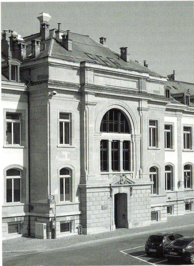
Fig.3 Ancienne Ecole de chimie de Lausanne, le corps central après la « rénovation douce ».
