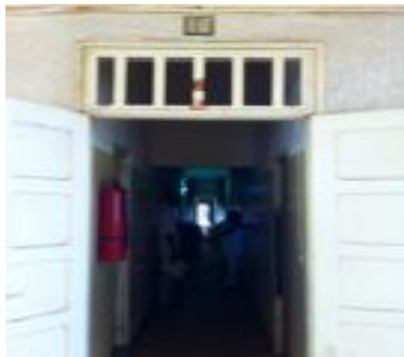
Photo n°5 : Entrée du pavillon 9
