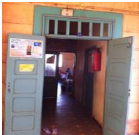
Photo n°8 : Entrée du pavillon 6
