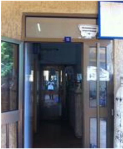
Photo n°6 : Entrée du pavillon 8
