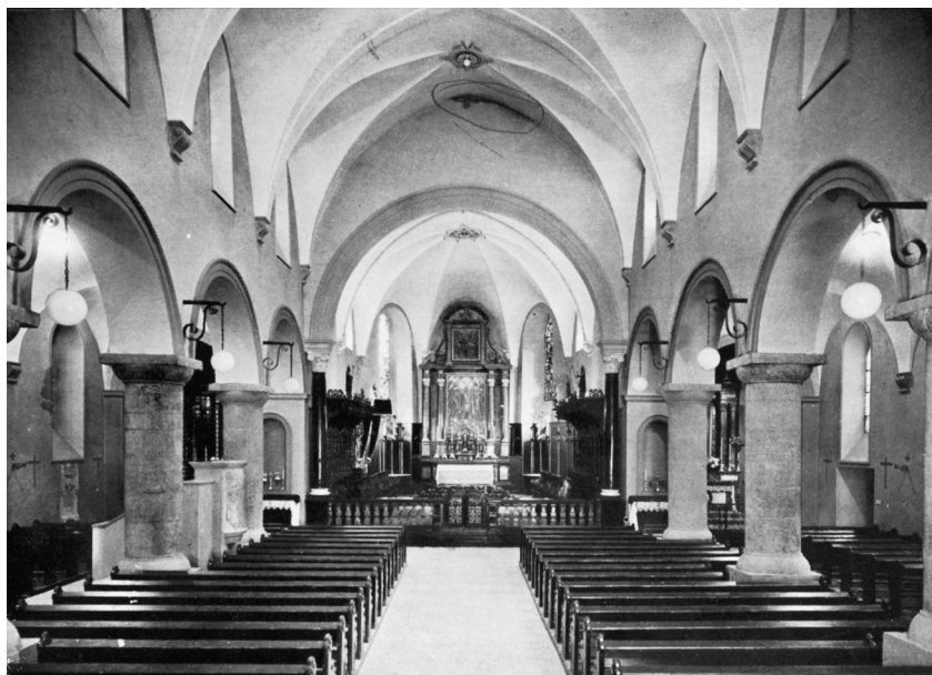
6 L'église abbatiale après la rénovation d'Adolphe Guyonnet.
