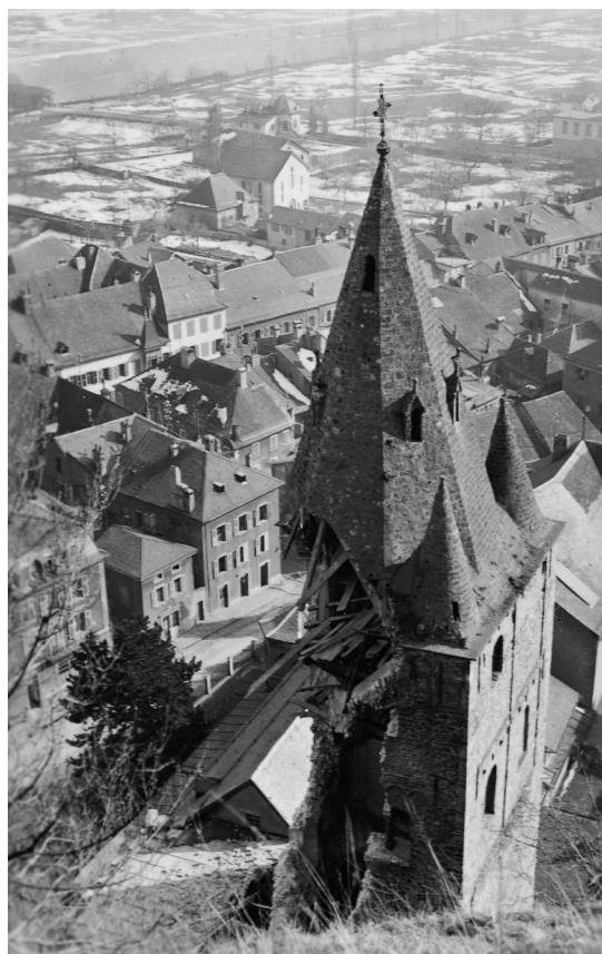
7 La tour avant son effondrement complet.
