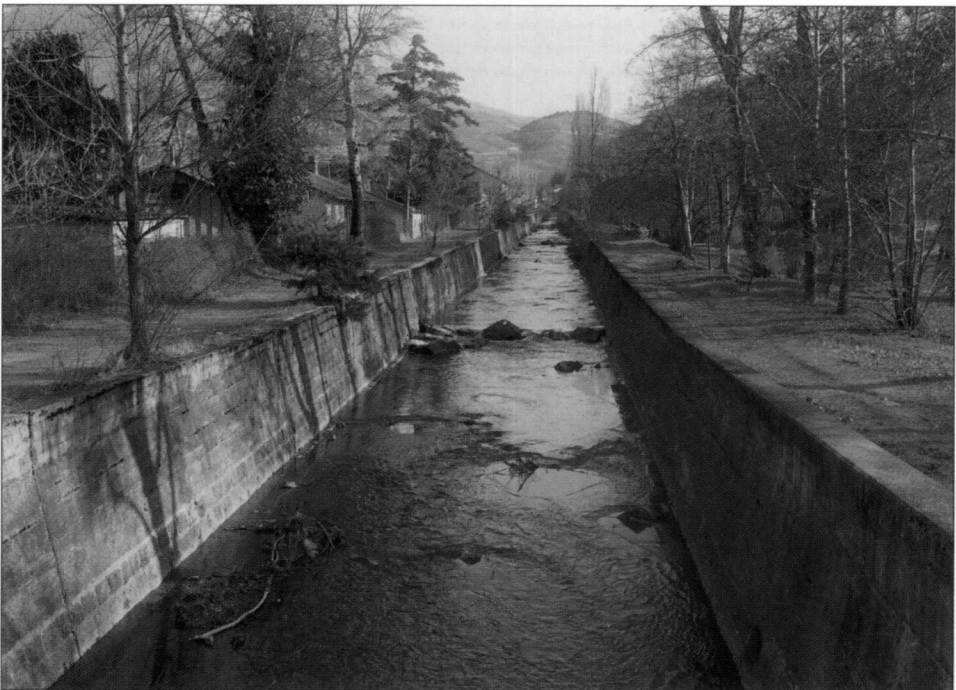
Fig. 24 – La Morge canalisée entre la route cantonale et la ligne de chemin de fer.
