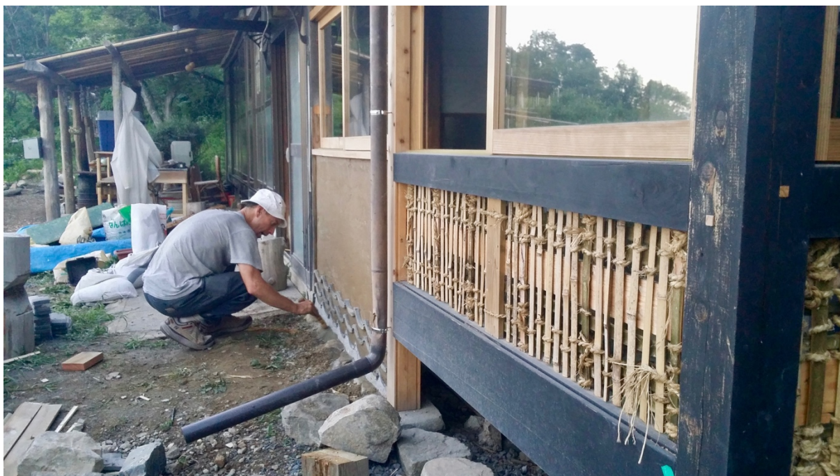
Figure 20 : Kyle finalise un travail de plâtrage sur un mur extérieur. Pamimomi, 2017.
