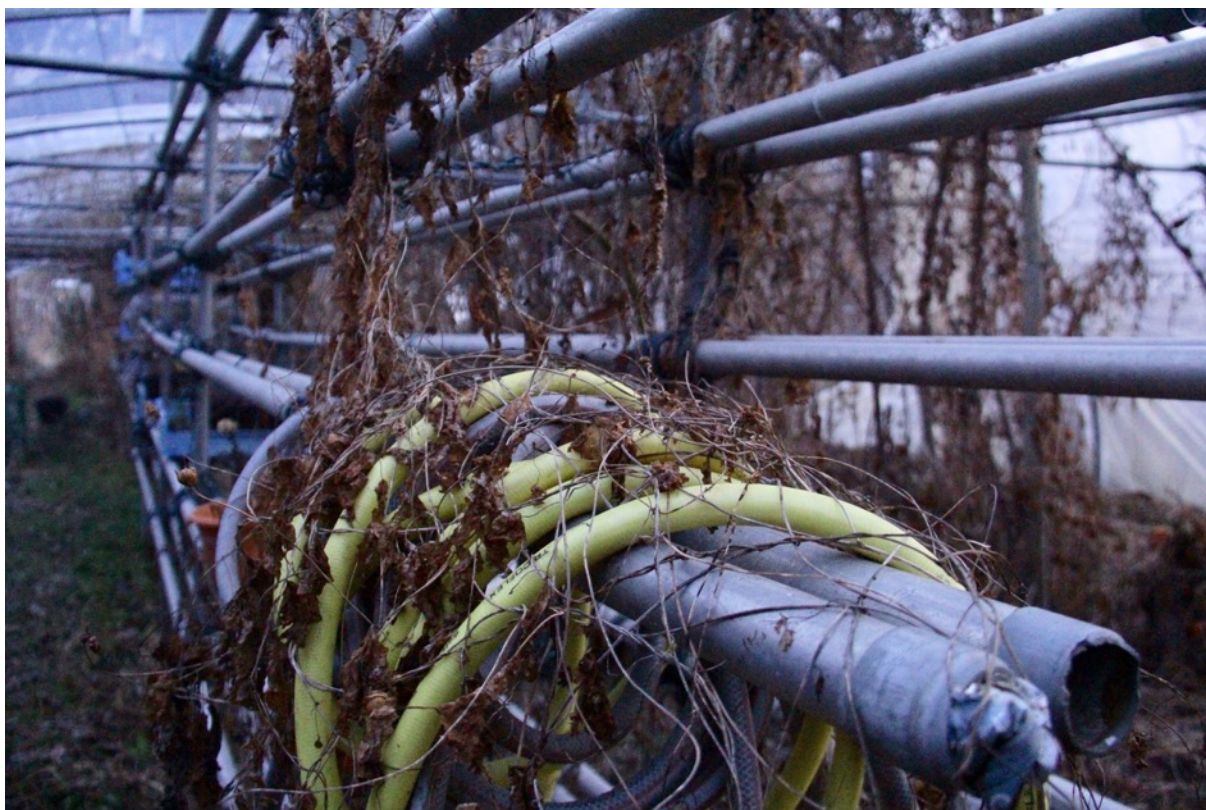
Figure 39: Structures métalliques dans un tunnel, à destination des plantes grimpantes. Jardins Permanents, janvier 2019
