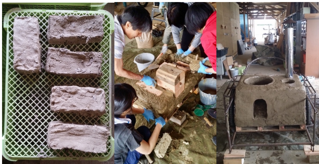
Figure 96 : Étapes de construction du kamado mobile à Kurkku Fields par Yotsui Shinji. Kisazuru (Chiba), juin 2019.
