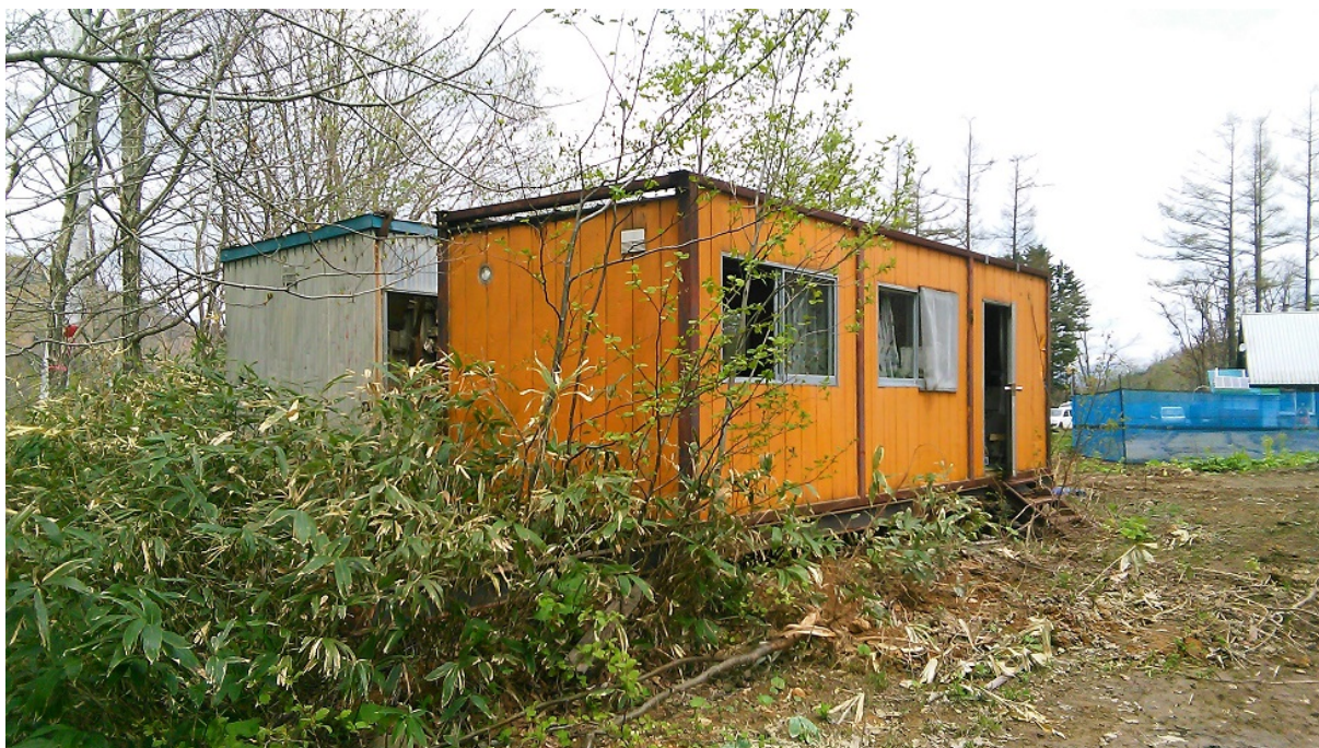
Figure 25 : Cabanon avant sa remise en état. Misumai, Sapporo, avril 2018. Crédits : Mitsukuri Yuki
