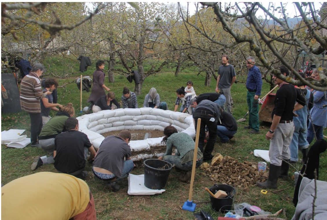
Figure 51 : Construction d'une jardinière en SuperAdobe lors du Permaculture Design Certificate à Cernier, Suisse. Octobre 2015.
