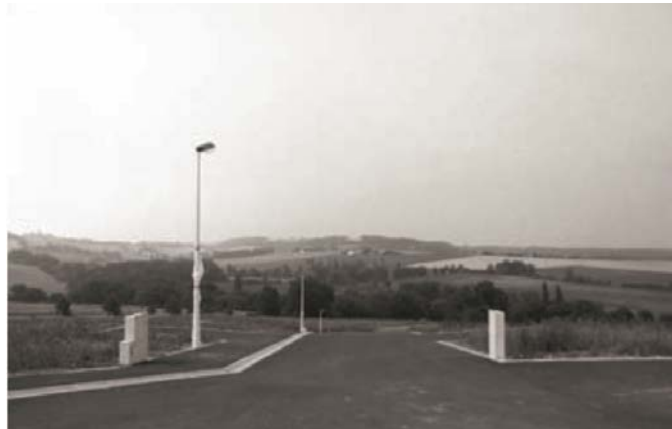
Figure 31. Aménagement routier des espaces ouverts communs (CAUE Lot-et-Garonne, 2005, p.8)
