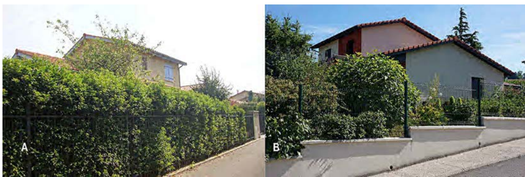
Figure 84. Traitement uniformisé des interfaces public/privé : A) Grille anthracite doublée d'une haie de lauriers du Portugal et d'un pommier à fleurs planté à l'intérieur de la parcelle à Solaize ; B) Muret bas en escalier soutenant le pied du talus, surmonté d'un grillage rigide et d'une haie variée à Montanay (L. Herrmann, 2013)
