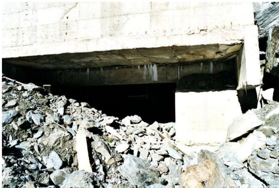
*Fig. 12* Vue sur les fondations de la station du Col des Gentianes. L'espace compris entre le bâtiment et la moraine mesure trois mètres environ. Il témoigne de l'affaissement de la moraine durant ces 20 dernières années (photo : C. Lambiel).
