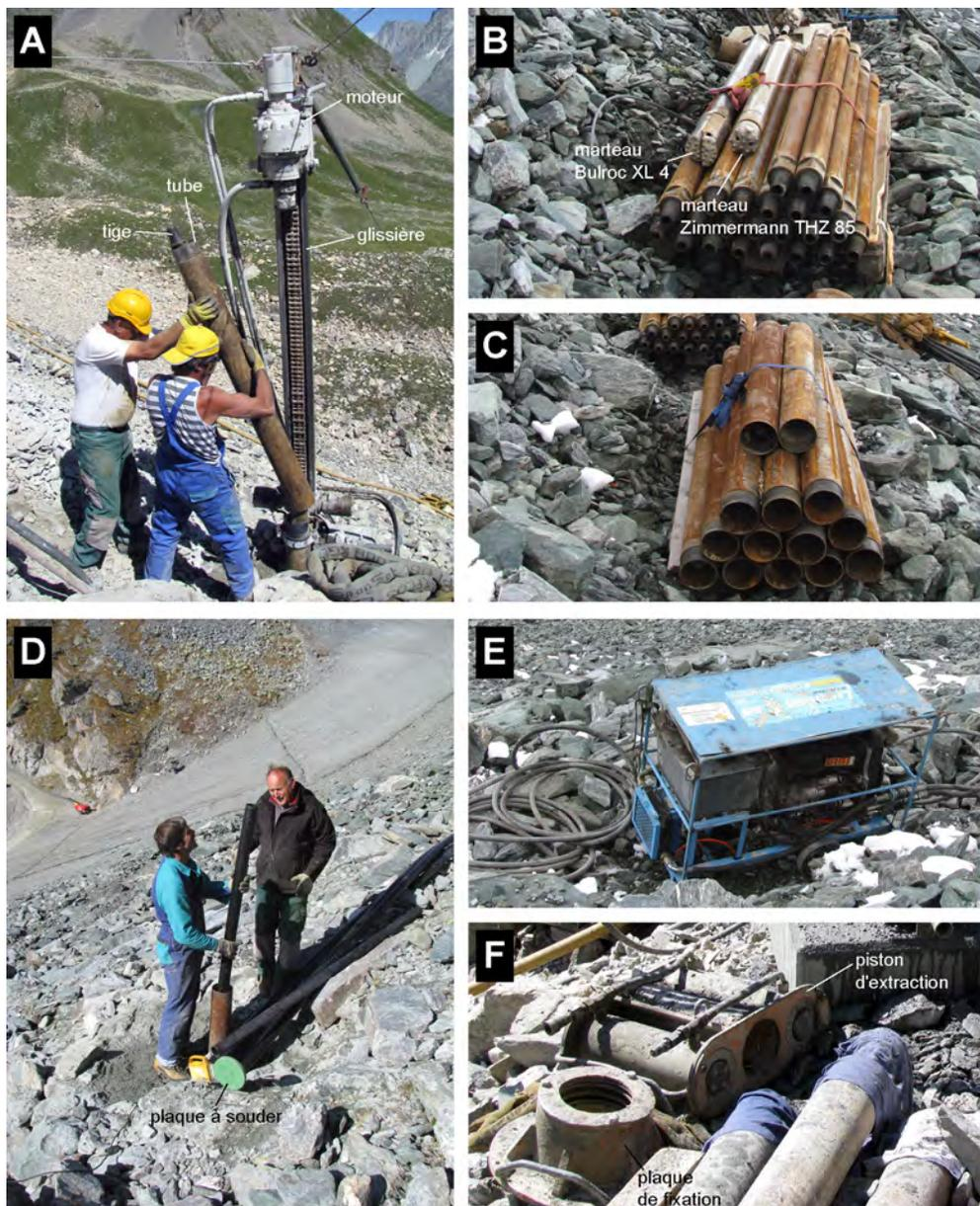
**Fig. II.7** – (A) Installation d'une tige de forage avec le tube sur la glissière. (B) Palette avec les tiges de forage et les deux marteaux de fond de trou utilisés. (C) Palette avec les tubes de forage. (D) Tubage définitif du forage avec des tubes PVC. (E) Centrale hydraulique 93 H. (F) Extracteur hydraulique HZV 15-400, avec plaque de fixation des tubes (50 kg) et piston d'extraction hydraulique (80 kg).
