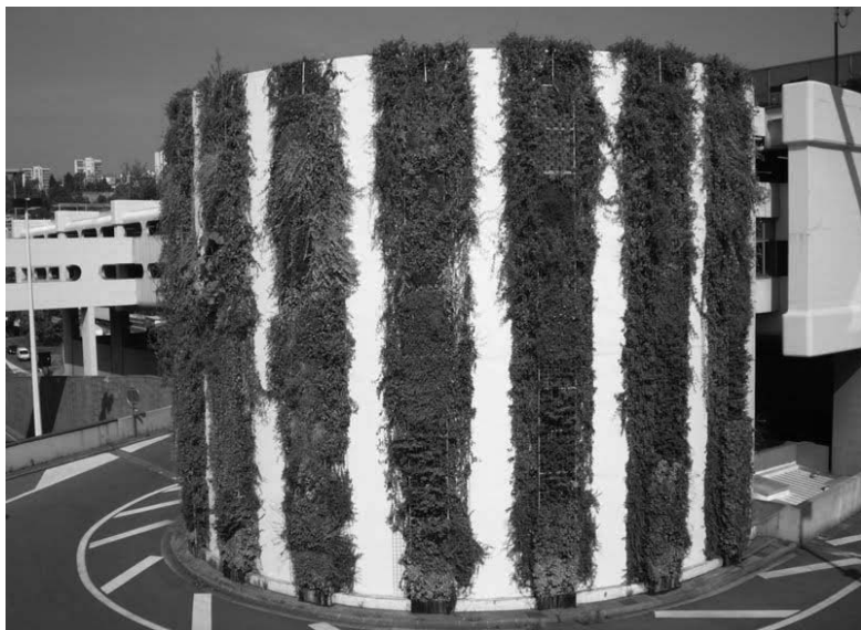
Figure 2.3: Mur végétal du centre d'échanges de Lyon-Perrache (Source : www.grandlyon.com , 2009)
