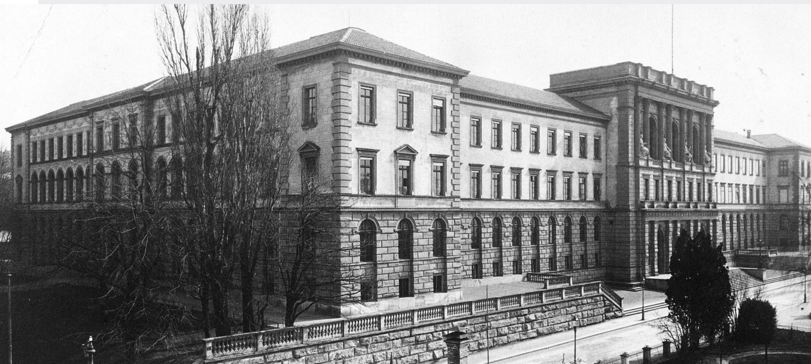
Fig. 1 : L'École polytechnique fédérale de Zurich, le bâtiment principal, Gottfried Semper arch., vers 1905.
