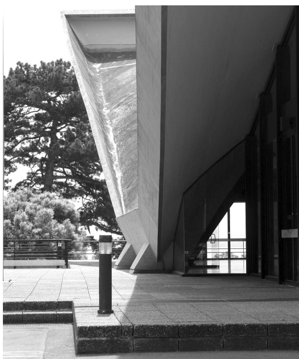
Fig. 3. : Aula de l'École polytechnique fédérale de Lausanne, 1961-1962, Jean Tschumi arch. Détail du voile de béton armé. Wikimedia commons, cliché Port(u o )s, 2008, CC BY 3.0.
