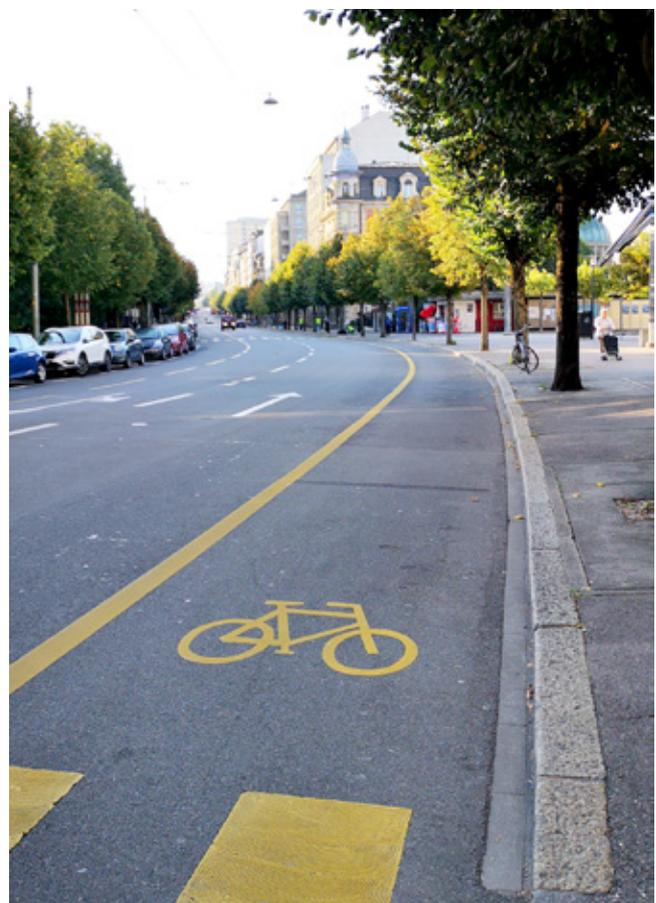
Fig. 8 : Situation d’arrivée : bande cyclable d’une largeur de 1,90 m (Photo : OUVEMA)
