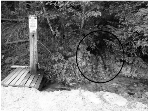
Arrivée dans le bisse de l'un des nombreux torrents adducteurs secondaires
