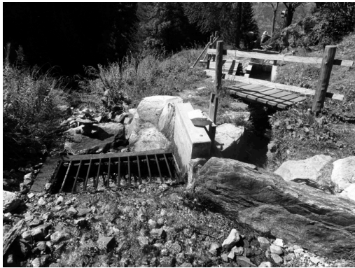
Prise d'eau (vue depuis le torrent)
