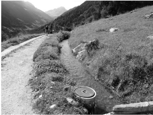
Multifonctionnalité des infrastructures (prise d'eau, chemin pédestre, tronçon non canalisé)
