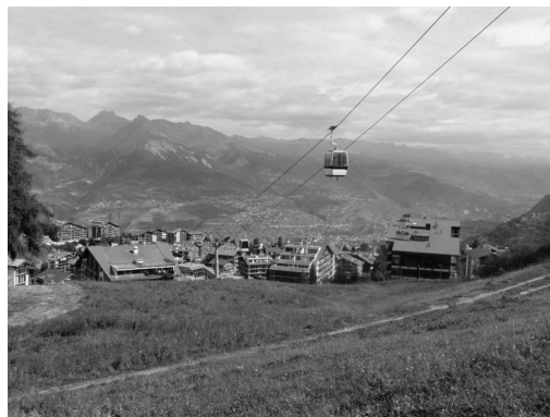
Nendaz Station, bisse enterré pour le passage de la piste de ski
