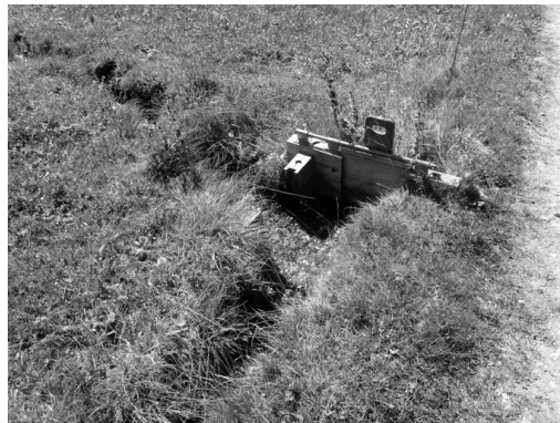
Ecluse de répartition sur la partie aval
