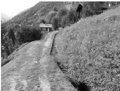
Chenaux métalliques aux abords d'une zone bâtie
