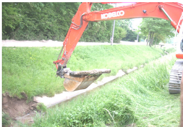
Photo 7 : Suppression de la cunette de béton et élargissement de la berge
