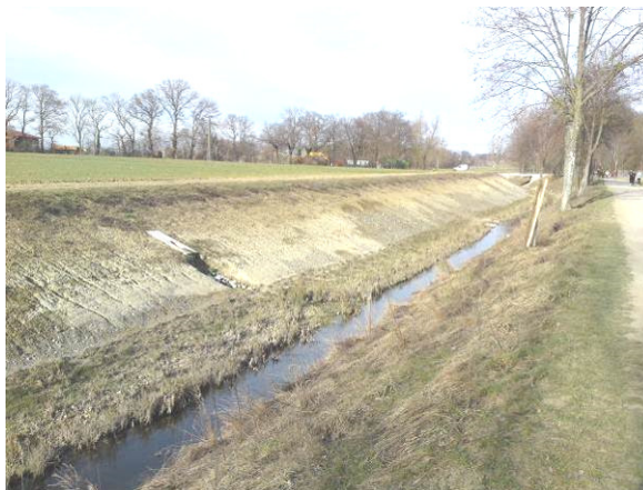
Photo 10 : Tronçon renaturé à l'aval du Pont de la Motte (2 ème étape) avec sortie de drainages
