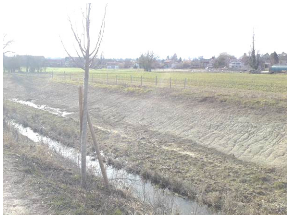
Photo 9 : Tronçon renaturé à l'aval du Pont de la Motte (2 ème étape) avec nouvelle plantation
