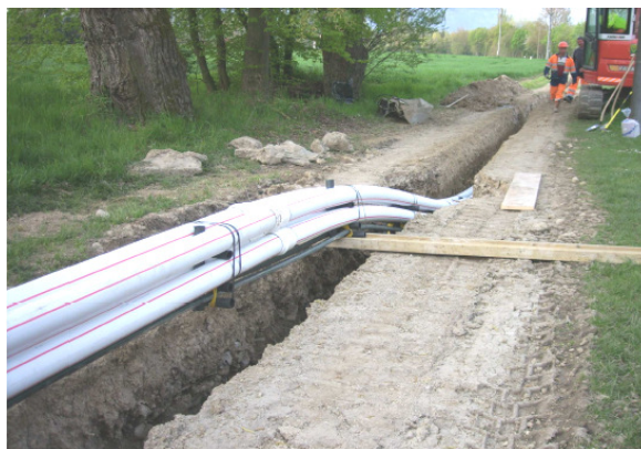
Photo 8 : Travaux d'enterrement de la ligne électrique
