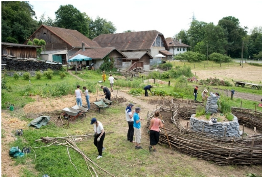
Figure 1. Chantier participatif dans le jardin aux 1000 mains (Source : Association Rovéréaz, 2016)
