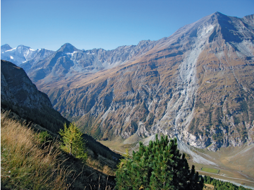
Fig. 11: Zone d'éboulement du flanc est de la Garda Bordon (Garde de Bordon) au-dessus des Plats de la Lé (val de Zinal). Photo M. Marthaler, 2009.
