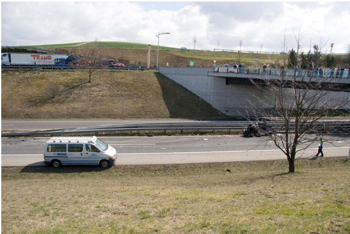
Figure 43 : Deuxième vue générale de l'accident (prise de vue en direction de l'Est).
