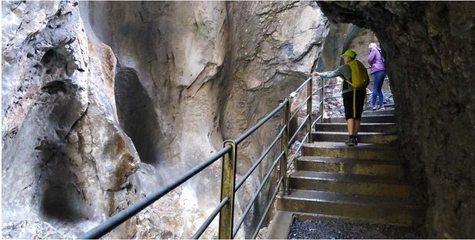
Figure 4. Chemin donnant accès à l'intérieur des gorges de Rosenloui (n° 5), creusé à la dynamite en 1901-1902.
