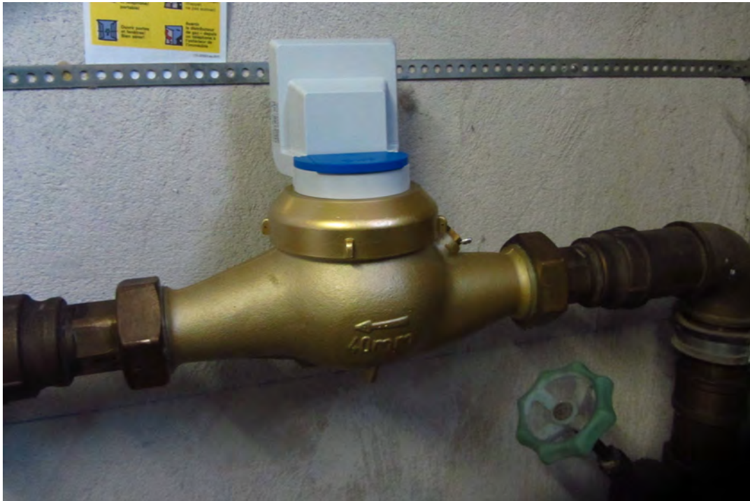
FIGURE 3.25 – Compteur domestique d'eau potable équipé d'une antenne radio pour la relève à distance.
