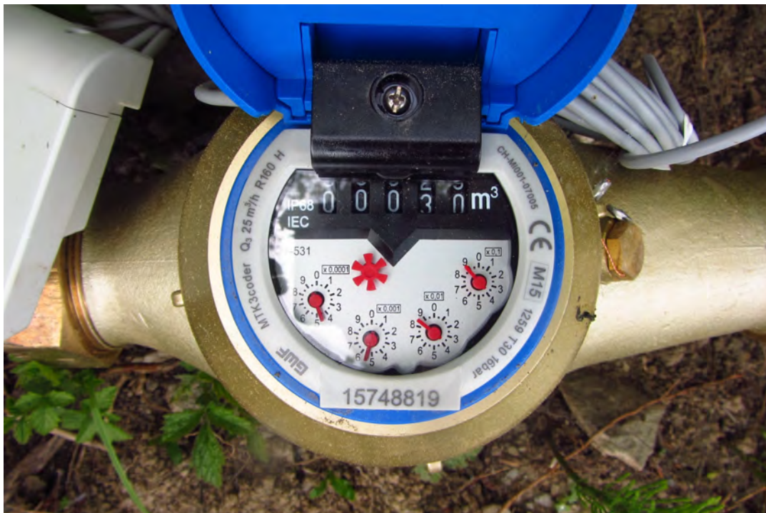
FIGURE 3.12 – Exemple de compteur d'eau potable domestique à Montana. Ce modèle-ci donne un index volumique avec une résolution d'un litre.
