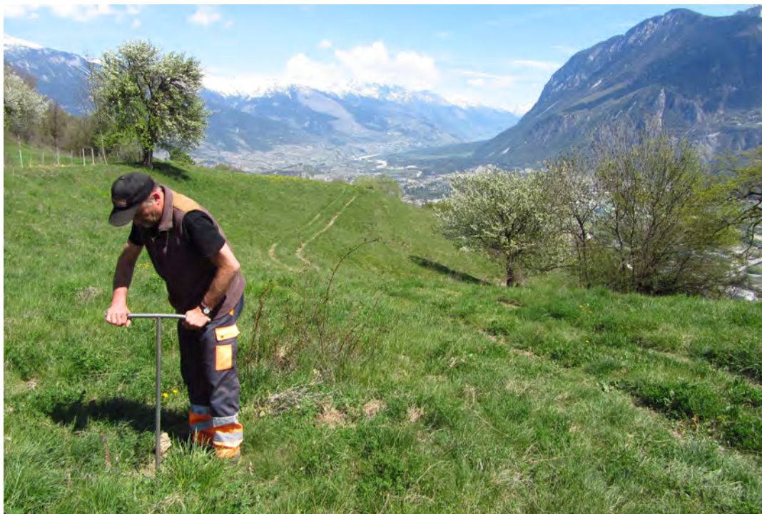
FIGURE 6.5 – Mise en eau du réseau d'irrigation par le fontainier communal, au niveau des prairies. Photographie : mai 2015.
