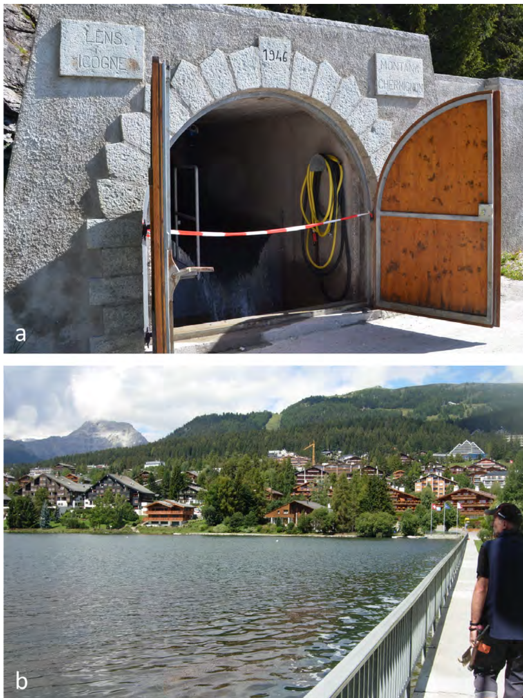
FIGURE 6.2 – Sortie du tunnel du Mont Lachaux (a), au niveau du répartiteur de Plans Mayens (commune de Lens). L'eau brute (visible sur l'image) et l'eau de source (mise en conduites) sont réparties entre Montana, Chermignon, Lens et Icogne. Vue du lac de la Moubra (b), où sont stockées les eaux brutes de Montana.
