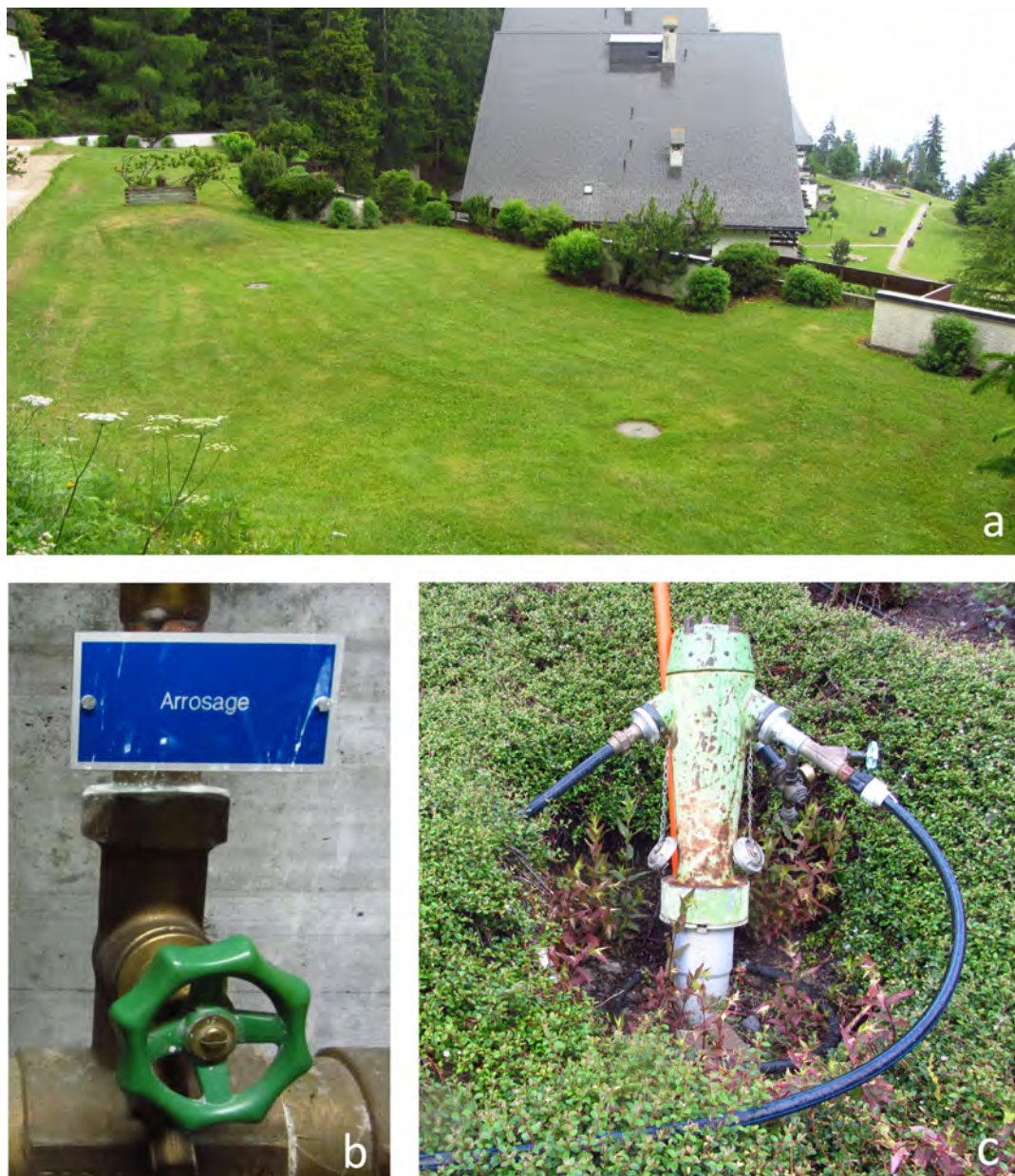
FIGURE 6.15 – Irrigation des jardins aux résidences Hauts de Crans : pelouses (a), vanne d'arrosage (b) et système d'arrosage sous pression (c). Photographies : juillet 2015.
