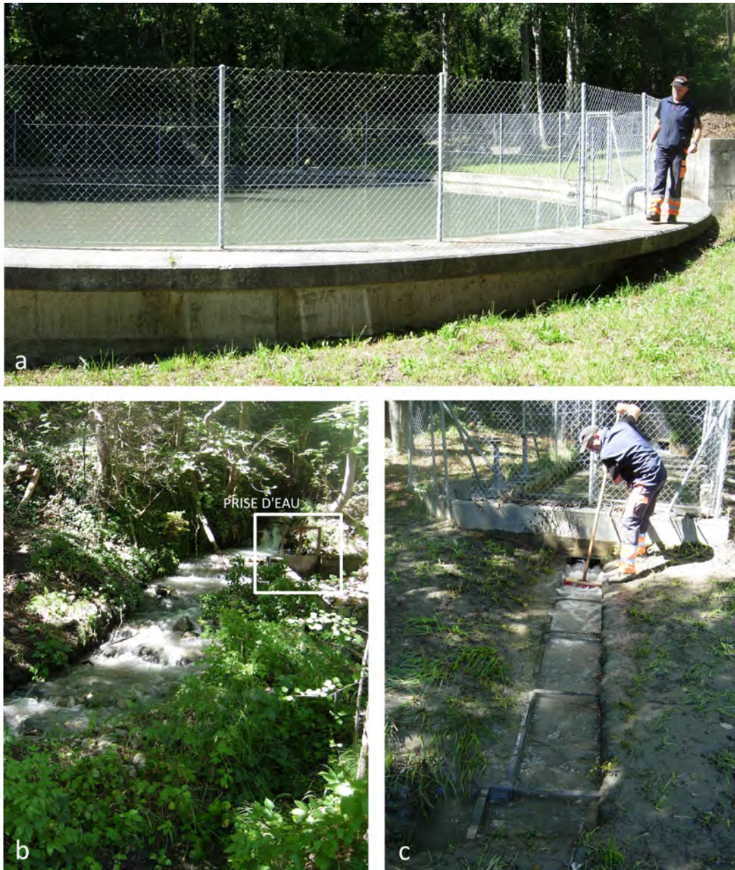
FIGURE 6.4 – Réservoir de Tsandemier (a), prise d'eau sur le torrent de Montana (b) et dessableur (c). Photographies : mai 2015.
