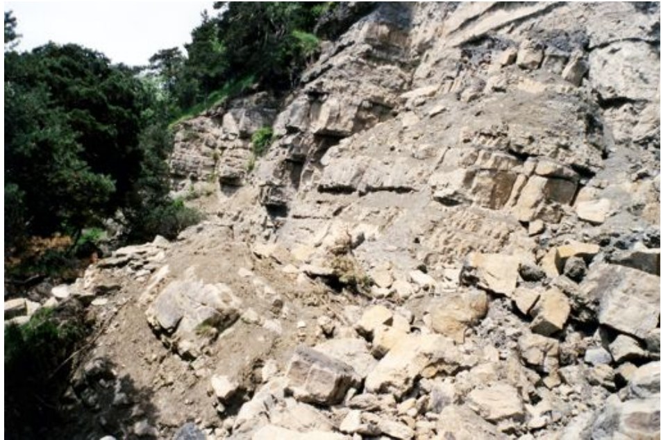
Fig. 9 Vue de la zone d'arrachement du glissement de La Cornalle-Les Luges (Epesses, Lavaux). L'alternance rythmique des niveaux gréseux et marneux, créée dans le bassin molassique en cours de subsidence au moment de l'érosion de la chaîne alpine naissante, est bien visible. Cette paroi est de plus tassée par blocs en mouvement le long de plans de failles listriques (Photo : J.-P. Pralong).
