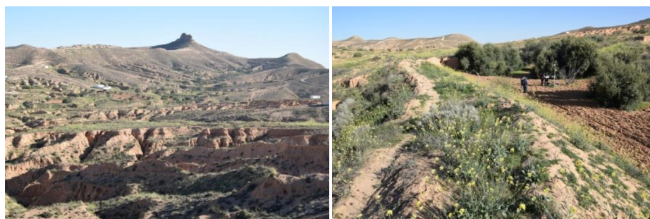
Figure 4. À gauche : Vue générale vers le nord-est du sous bassin de Chaabet el Fougania ; À droite : station installée dans un Jessour à tabia confectionnée manuellement, ce qui lui a permis de résister aux fortes pluies.
