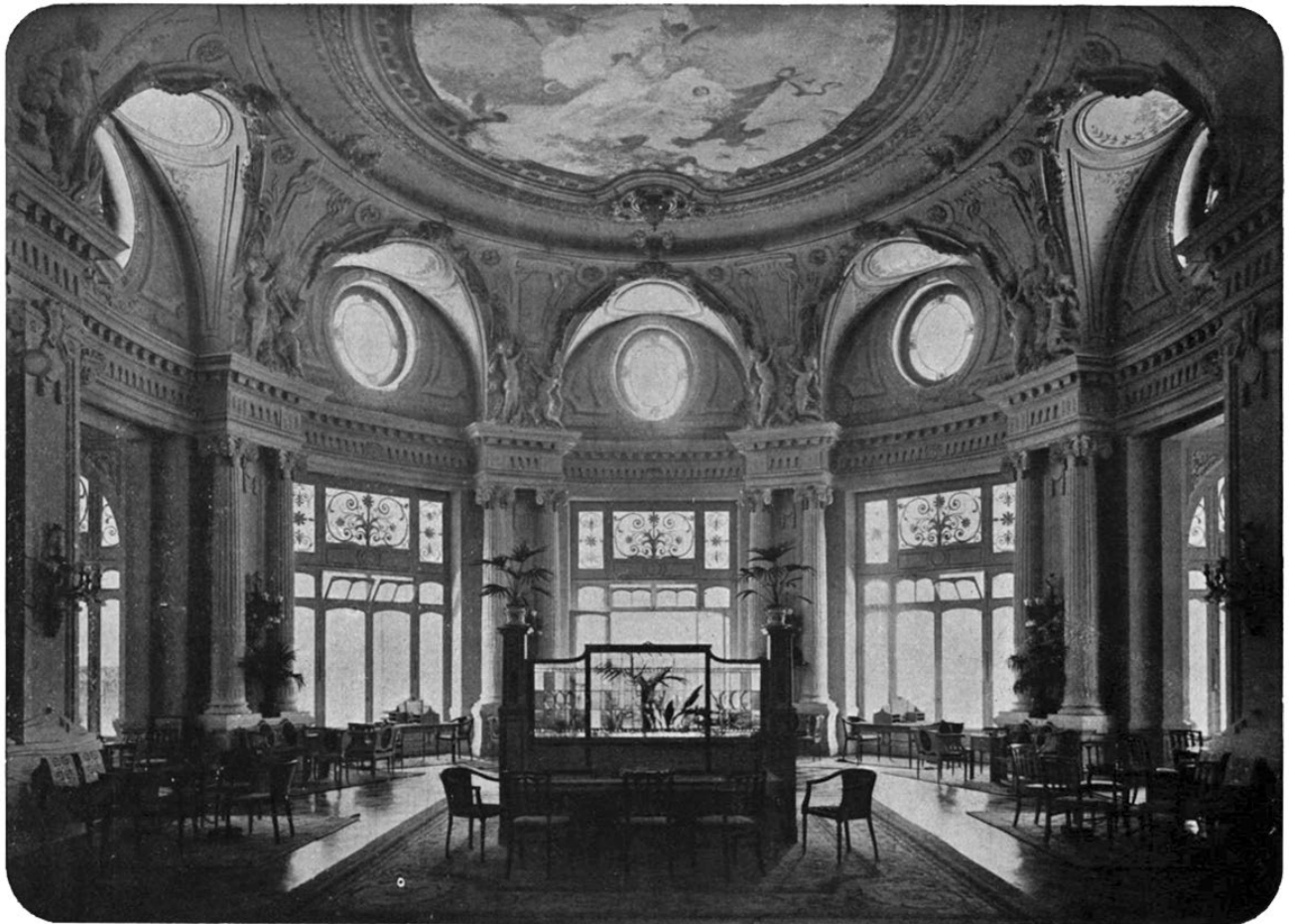
Fig. 1 : Lausanne, Hôtel Beau-Rivage Palace, le hall. Tiré de : Béton armé , 1908.
