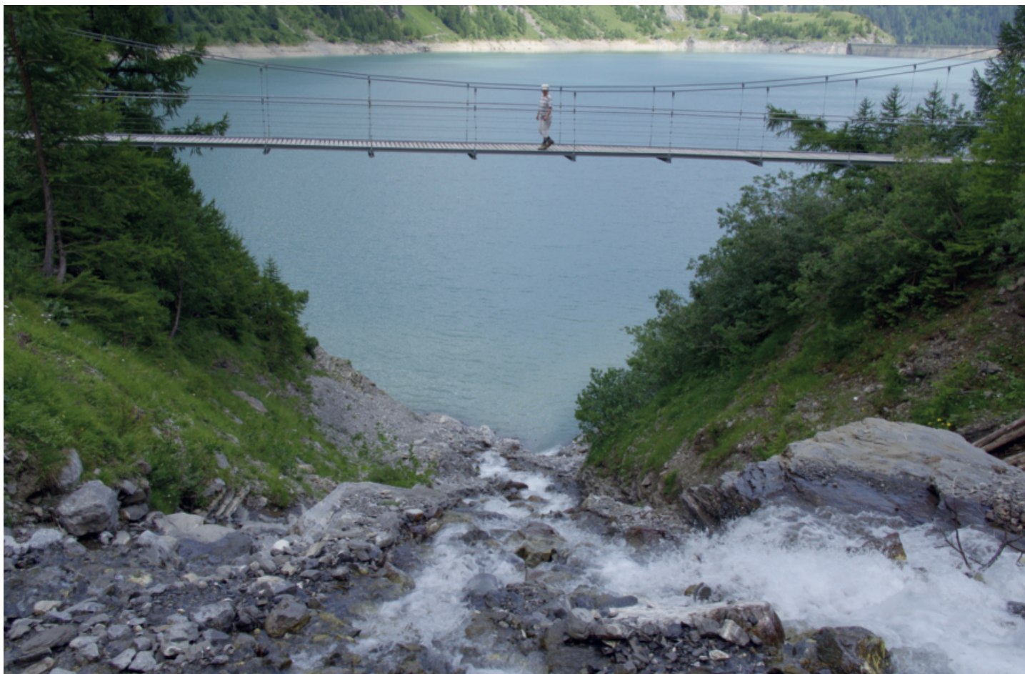
Barrage de Tseuzier. (Martin Fardey)
