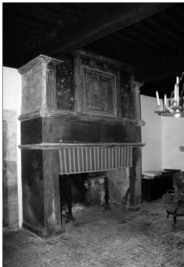
Figure 1 : Château de Bouisse, cheminée du rez de chaussée.
