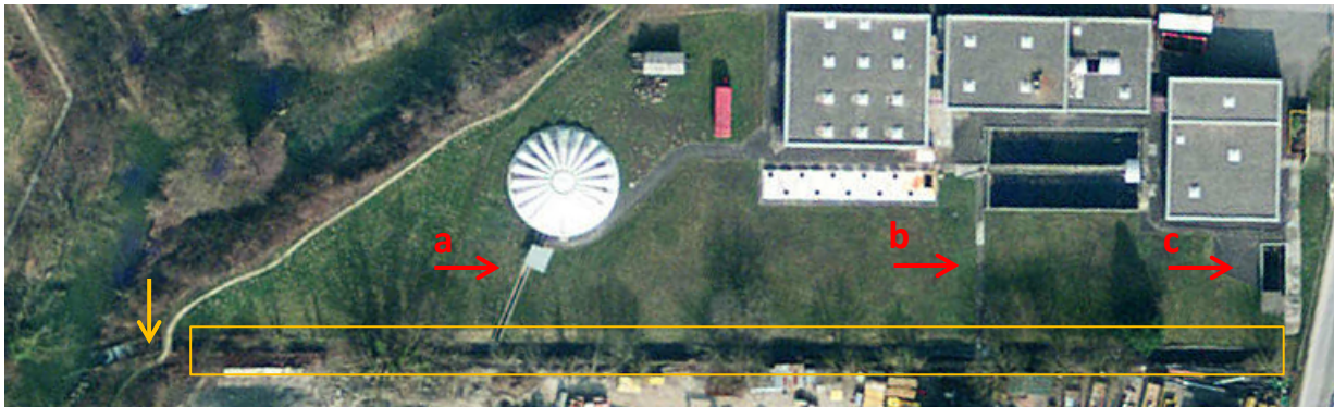
Figure 60 : Le site d'échantillonnage sélectionné dans cette étude pour le rejet de la STEP de Bussigny (flèche orange horizontale) se situe à l'extrémité du canal (rectangle orange) récoltant les eaux traitées (a), les eaux d'une surverse intermédiaire (b) et les eaux provenant du déversoir d'orage (c).
