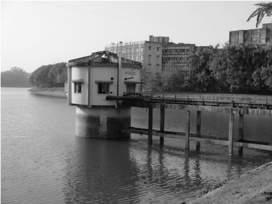
Figure 4 : Dudhiya Talav, lac transformé en réservoir en eau (source : René Véron)
