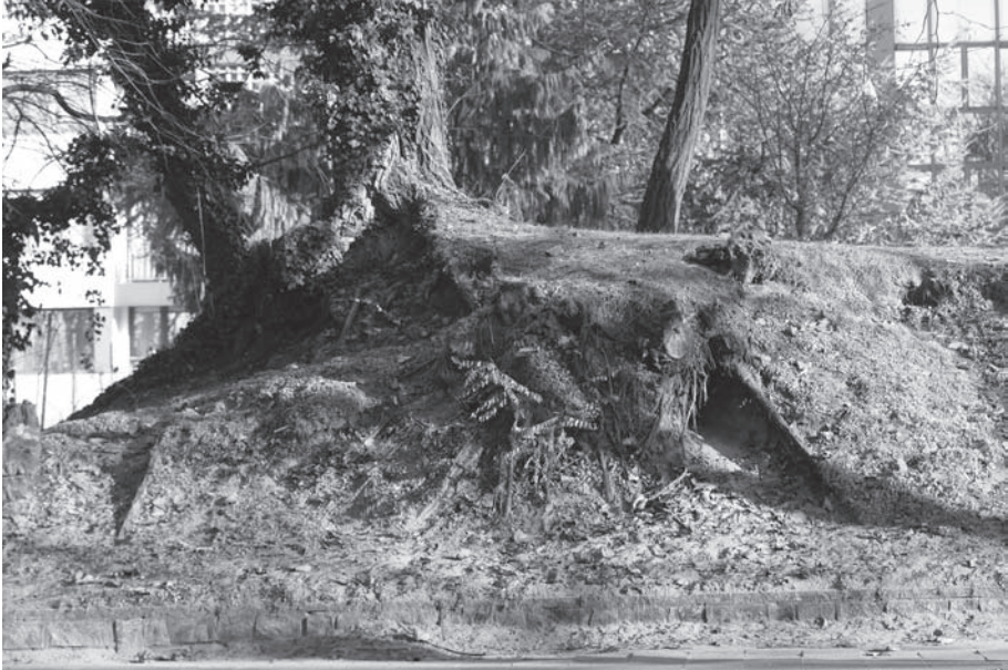
Figure 2 : Terrier au pied de bâtiments sociaux (Chloé Vanden Berghé, décembre 2022).
