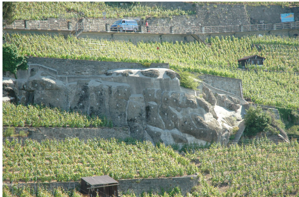
Fig. 7 Banc de conglomérats et consolidation artificielle entre Epesses et Chexbres (photo : M. Bertholet et R. Vuagniaux).
