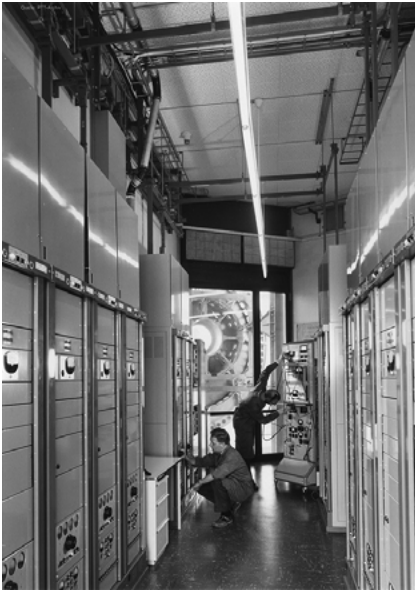
Abb. 3: Richtfunkanlage am Albis, 1953. PTT-Archiv, OK-0004:04.
