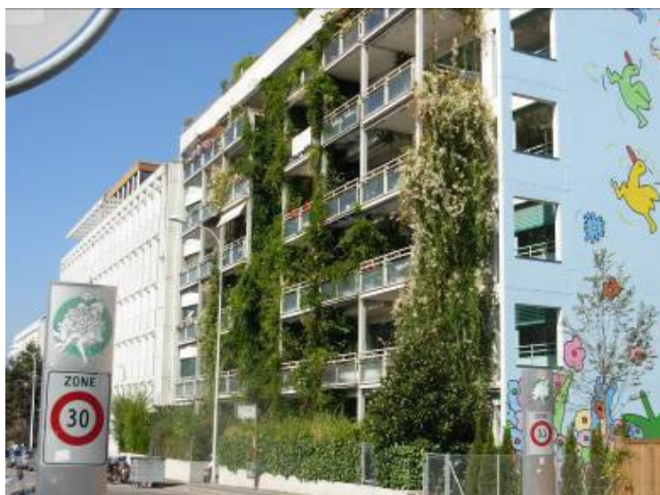
Intégration de végétaux en façade à la rue Gavard (GE) - Crédit photo : E. Renaud
