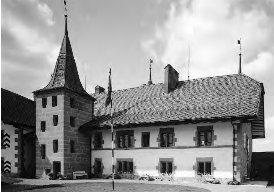
860. Château de Rue, corps de logis élevé en 1619–1621 par LL.EE. de Fribourg, façade côté cour avec sa tour d'escalier de plan pratiquement carré. Etat en 1998. Les fenêtres sont dotées d'un simple meneau. On observe deux triplets, caractéristiques de la Suisse alémanique. (SBC-FR, Y. Eigenmann)
