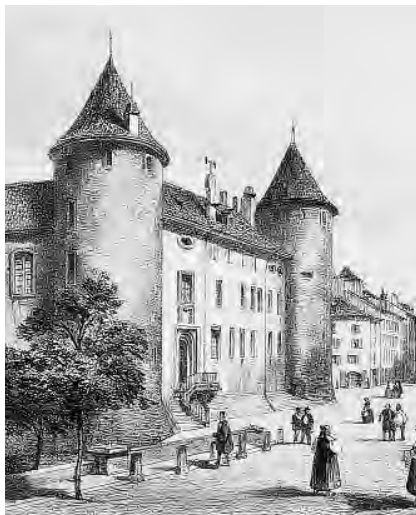
897. Château d'Yverdon, la façade nord vers 1840, gravure de Derooy, lithographiée par Müller. Cette façade, le résultat d'apports divers, avait fini par obtenir une certaine tenue dans l'esprit néoclassique qui admettait les grandes surfaces crépies. Les deux fenêtres surmontées des œils-de-bœuf en dessus de l'entrée ont été conçues en 1810 de façon symétrique par rapport aux ouvertures proches de la tour nord, créées en 1809. Cette organisation suggérait ainsi une façade tripartite, formée d'une large zone centrale flanquée à ses extrémités de deux corps latéraux à deux axes, soulignés encore par les tuyaux de descente placés en 1821. L'entrée, et certaines baies qu'il a fallu adapter aux structures préexistantes, rompent cependant avec la stricte symétrie, en un mouvement que n'aurait pas dédaigné l'esthétique médiévale. Une récurrence qu'a imposée la nature première de l'édifice. (MY, Fibbi-Aeppli)
