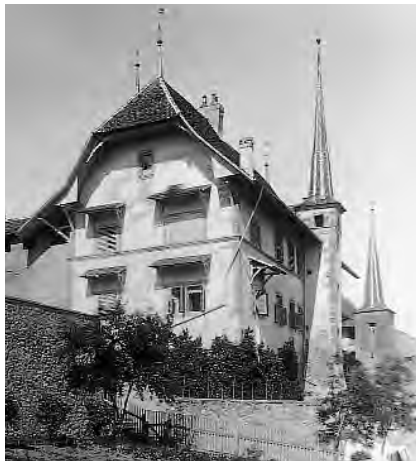
857. Château de Romont, corps de logis construit sur le front oriental en 1581–1587, après l'effondrement des édifices médiévaux, état en 1899. La tour-latrines, de petites proportions, est reliée par un corridor à la tour d'escalier polygonale donnant sur la cour intérieure. (SBC-FR)
