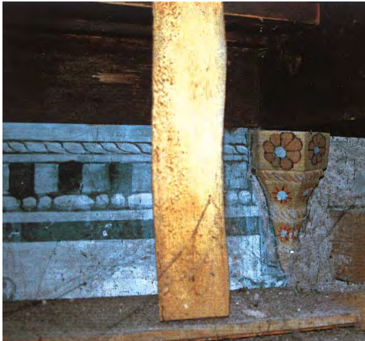
816. Château d'Oron, ancienne «chambre du pont». Restes du décor peint sous le plafond à la française visible actuellement depuis les combles, au-dessus du plafond en bois de l'actuelle «salle de musique». (André Locher)
