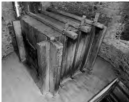
856. Estavayer-le-Lac, étage d'entrée de la grande tour. Vue plongeante sur une ancienne prison, tout à fait comparable à celle de ce type conservée au château de Bulle, édifiée au XVI e siècle certainement. Etat en 1998. (Fibbi-Aeppli)
