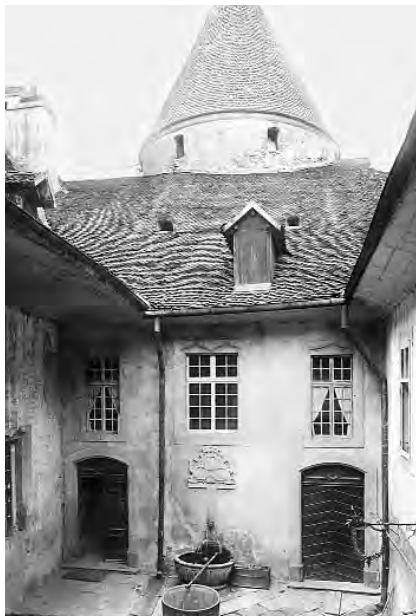
819. Château d'Oron, cour intérieure, vue en direction du réduit seigneurial, façade du grand vestibule, édifiée vers 1731. Etat en 1899. Les encadrements des deux portes, comme leurs vantaux, pourraient être ceux de l'origine. Le niveau du rez-de-chaussée desservait les fours, les prisons et des celliers. La fontaine aux armes de LL.EE., due au marbrier de Vevey, Dorët, a provoqué l'obturation d'une fenêtre basse en 1747-1749. Les baies de l'étage sont un pastiche néogothique de la fin du XIXe siècle. (AFMH)
