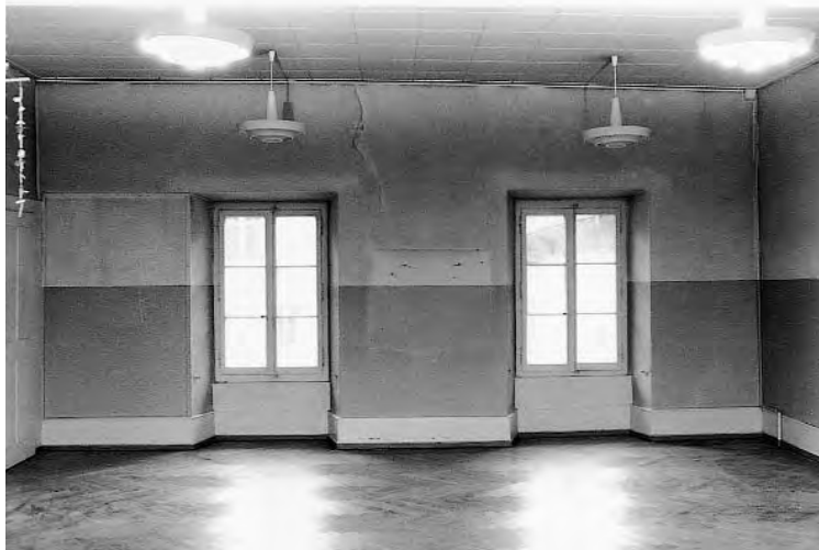
991. Château d'Yverdon, étage de l'aile sud, salle [219-4] vue en direction du nord. Le sol est formé d'un parquet en lamelles de sapin posées en chevrons, l'éclairage est celui en vigueur dans maints édifices scolaires dans les années 1960, les deux fenêtres donnant sur la cour seront remplacées par la restitution d'une croisée de 1494–1495. État en 1974. (P. Margot)
