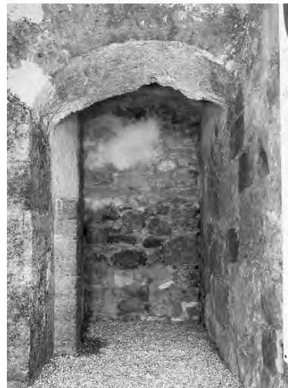
68. Château d'Yverdon, aile sud, cave [020], poterne donnant à l'origine dans la cour de la grande tour, plus vaste qu'aujourd'hui. Etat en 1997. Le montant oriental en grès de La Molière est conservé alors que celui de l'ouest a été intégré au mur définissant l'aile sud primitive, reconstruit après les guerres de Bourgogne. La porte n'a été condamnée qu'en 1670 et remplacée par celle placée contre la grande tour pour permettre d'accéder à l'escalier à vis construit cette année-là. (PBC-VD, Fibbi-Aeppli)
