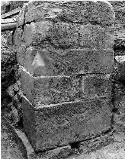
42. Yverdon, front occidental des écuries médiévales du château, dans l'axe de l'actuelle rue du Casino. Vue prise de l'angle de l'actuel café du Château, en direction du sud-est. La façade est ponctuée de deux imposants contreforts dont la fonction n'est pas précisée. Ils soutenaient sans doute un couvert ou une galerie. Etat lors des fouilles conduites en 1989. (Fibbi-Aeppli).
