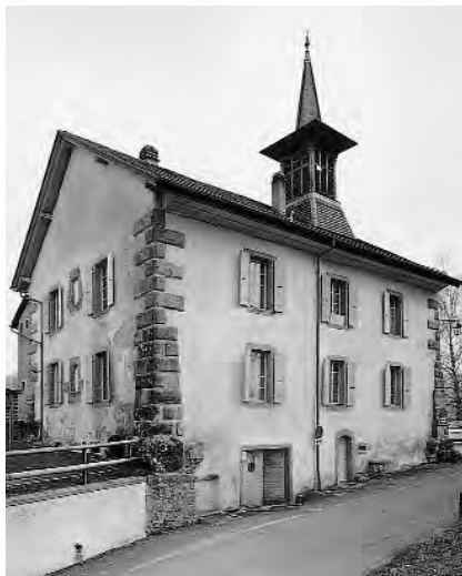
811. Oron-le-Châtel, ancienne école primaire communale. Les angles de cet édifice sont marqués par des chaînes et contreforts à bossages qui caractérisent les travaux d'Antoine Pauly en 1588–1590. Il abritait à l'origine un grenier dont on observe encore quelques fenêtres étroites, maintenant obturées. Etat en 2002. (R. Gindroz)
