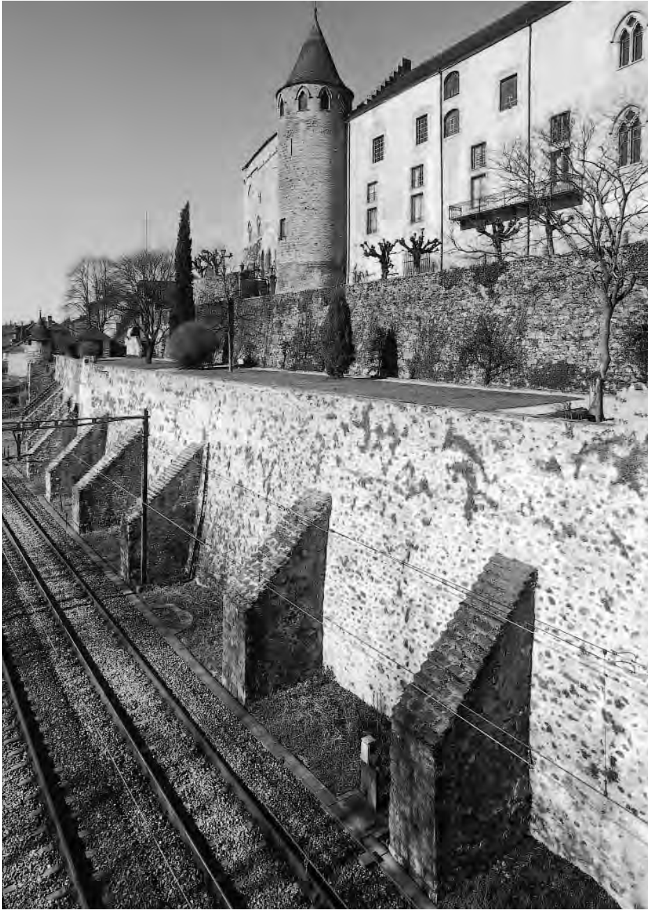
389. Château de Grandson, front sud. Mur de braies aux dix contreforts édifié lors du chantier de 1277–1281. Le mur de la terrasse supérieure, devant le grand corps de logis sud, est en revanche tardif, du XVIIIe siècle seulement. Etat en 1998. (Fibbi-Aeppli)
