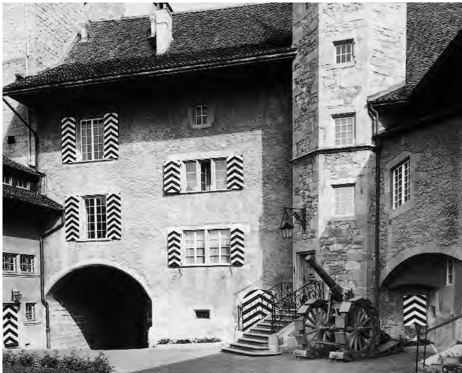
834. Château de Morat, cour intérieure, vue en direction de l'est, corps de logis et tour d'escalier construits dans le secteur de l'entrée en 1539–1541. L'escalier en rampe droite de pierre jaune de Neuchâtel et les garde-corps en feronnerie faits de motifs rococo, comme la galerie sur arcade oblique conduisant aux corps de logis médiévaux appuyés contre la courtine sud-ouest, font partie des grandes transformations de 1752–1760, lesquelles introduisent les fenêtres simplement rectangulaires d'esprit classique. Photo de 1920, après la suppression des crépis et la restauration historicisante conduite par Frédéric Broillet avec le soutien de la Confédération, représentée par Albert Naef. (SBC-FR)
