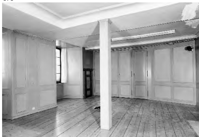
675. Château d'Yverdon, aile nord, rez-de-chaussée, espace [107-1 à 3], vue vers l'est, vers la salle d'audience de 1778. Etat en 1987. La fenêtre et les armoires sont de 1778. Un fourneau de faïence a été placé dans l'angle sud de la pièce, remplacé par la suite par des poêles en fer. (Fibbi-Aeppli)
