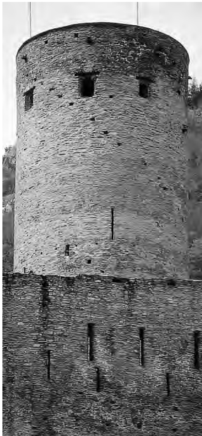
190. Martigny, château de La Bâtiaz, partie haute de la grande tour, vers 1272 et 1281, vue de l'est. Les trous de poutre ayant soutenu l'échafaudage oblique d'acheminement des matériaux sont bien visibles. Au-dessus d'une des baies-créneaux, les deux trous supérieurs se situent dans la surélévation de 1281 : l'échafaudage a sans doute été remonté et utilisé pour ces travaux ultérieurs. Les chantpleures et les gargouilles modernes sont peut-être à l'emplacement de celles qui ont existé à l'origine pour évacuer les eaux pluviales du nouveau chemin de ronde. Etat en 2003. (D. de Raemy)
