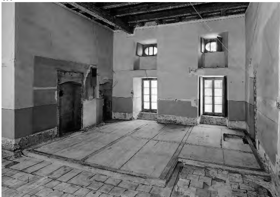
893. Château d'Yverdon, extrémité septentrionale de l'aile ouest, partie nord de la salle [210]. Etat en 1990. Le volume unitaire de cette salle tel qu'on le voit sur cette photo a été réalisé en 1887 pour la classe de physique et chimie du collège. Cet espace a ensuite été utilisé par le musée pour l'exposition des sciences naturelles depuis 1914. Le plancher de sapin à frises de chêne a été posé en 1809 pour la chambre de madame Pestalozzi. C'est à cette occasion que sont ouvertes les deux fenêtres ainsi que les oculi qui les surmontent. On devine les restes du trumeau en plâtre de la cheminée qui chauffait la pièce dont le plafond se situait juste au-dessus des fenêtres. Au premier plan, le sol en terre cuite remonte aux travaux de 1536-1539 pour les greniers de LL.EE. (Fibbi-Aeppli)
