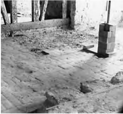
702. Château d'Yverdon, aile sud, grand vestibule sombre [120-1 à 4], vue du sol en terres cuites retrouvé sous les planchers lors des travaux de 1963. On observe, contre le mur en pan-de-bois de 1685 et contre la courtine sud, une zone dépourvue de carreaux, lesquels ont été enlevés et remplacés sans doute par un plancher en 1761 pour une chambre des domestiques. Au premier plan, on voit l'extrémité d'une épaisse dalle en béton (armé?) posée en 1943 sur la voûte pour protéger le poste de commandement installé dans la cave, à l'angle sud de l'aile occidentale; cette dalle a été enlevée en 1965. (P. Margot)
