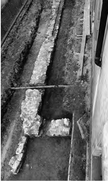
716. Yverdon, rue du Casino, fondations des façades occidentale et méridionale des anciennes écuries de LL.EE. dépendantes du château, réédifiées en 1698 sous la direction du secrétaire baillival Marc de Treytorrens. Etat en 1989. (Fibbi-Aeppli)
