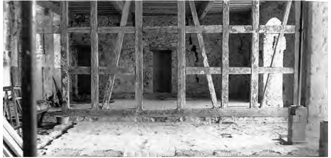
697. Château d'Yverdon, aile sud, rez-de-chaussée, vue en direction de l'est. Etat en 1962. Mur en pan-de-bois construit dans les années 1630 pour la nouvelle chambre du receveur et des armoiries [120-5], en cours de démontage. Quelques bois ont été récupérés pour la reconstitution du local [116]. Au premier plan, la zone qui va devenir dès 1685 la «grande allée». (P. Margot)
