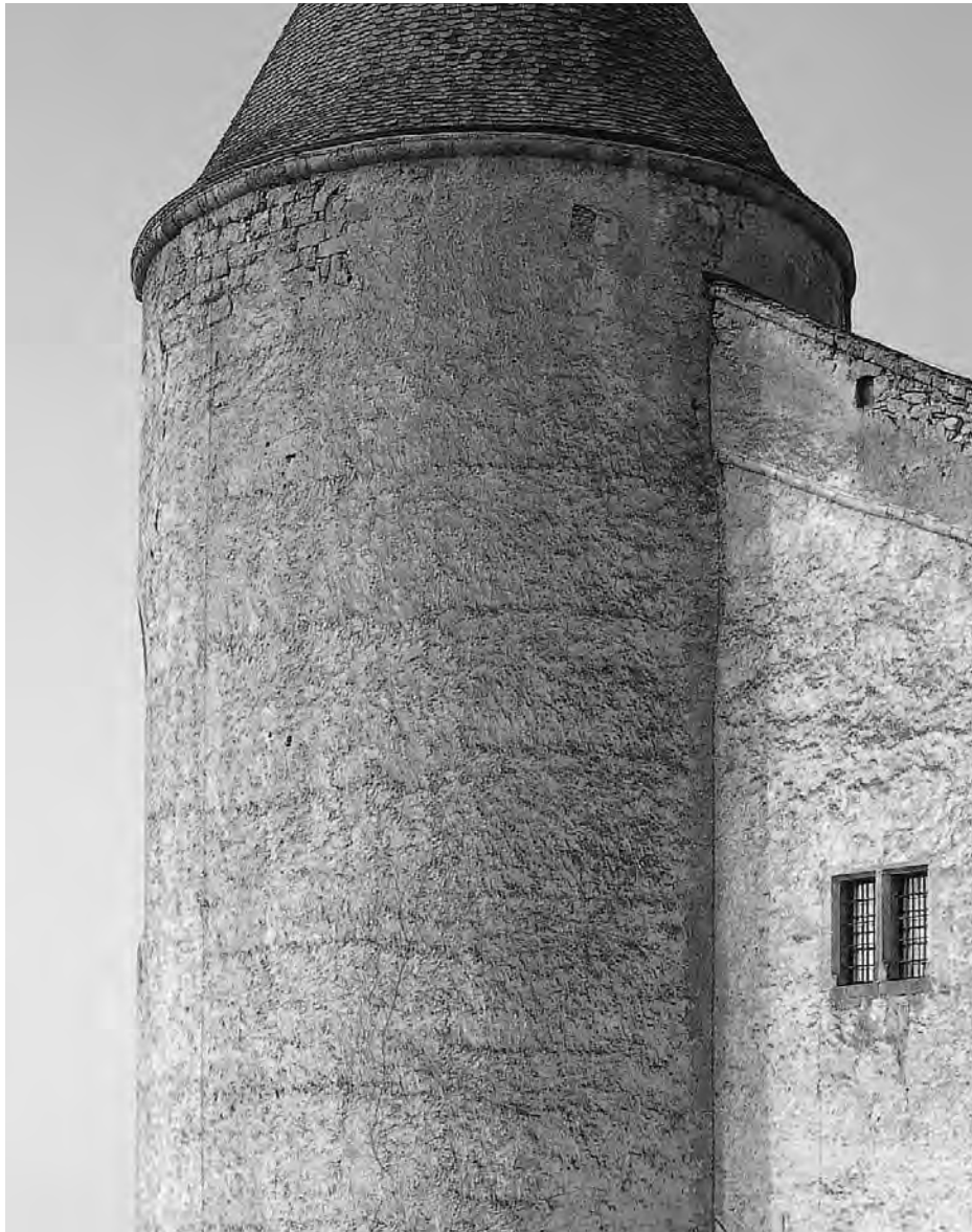
295. Château de Champvent, vers 1295–1300. Tour de la chapelle vue du nord. De ce côté, l'enduit ancien du XVe siècle est encore bien conservé, même si le faux appareil rouge est effacé. Etat en 1999. (I. Ashdown)
