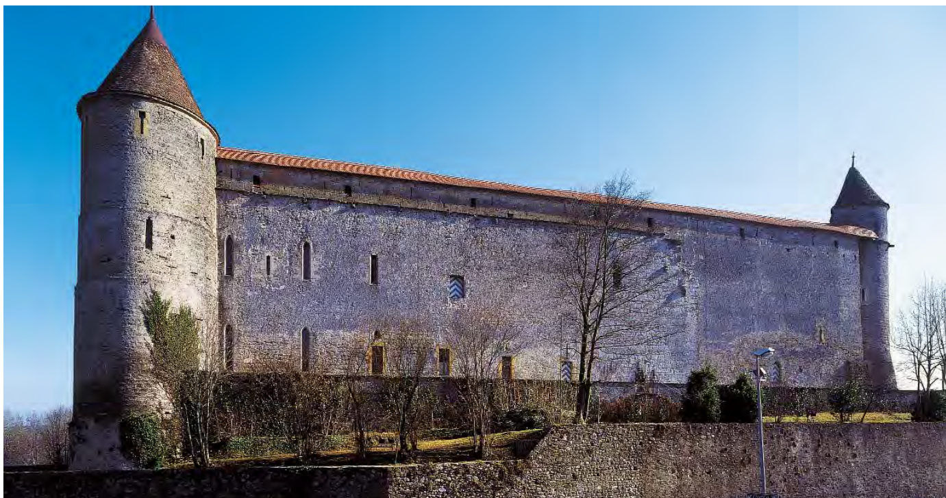
Château de Grandson, grande courtine nord. Etat en 2004. (Fibbi-Aeppli)
