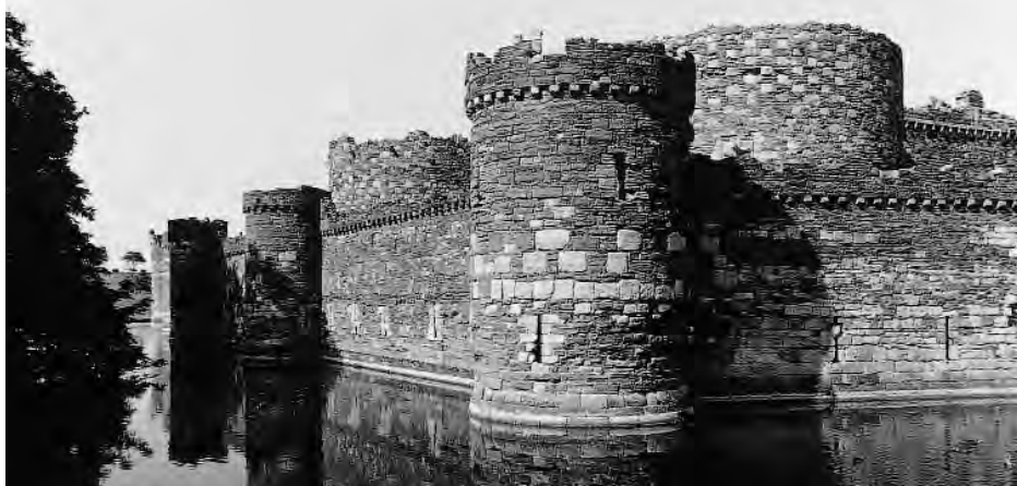
469. Château royal de Beaumaris (Pays de Galles), commencé en 1295 sous la direction de Jacques de Saint-Georges. Enceinte périphérique systématiquement percée d'archères dans les parties basses. Les parapets des chemins de ronde sont légèrement saillants, posées sur des modillons, parti alors fréquent en Pays de Galles. La recherche d'un équilibre parfait dans les masses architecturales ne donne pas l'impression que ce château est une œuvre colossale (voir plan fig. 470). Les courtines forment un quadrilatère de 75 m x 68 m; au niveau du sol, l'épaisseur de celles-ci est de plus de 5 m, ayant permis l'aménagement, au tiers de leur hauteur, d'impressionnantes gaines défensives percées d'archères. Le gabarit hors-œuvre de chacun des keep-gate-houses , réservés à la résidence noble, est de 30 m x 25 m, autorisant l'aménagement de très vastes salles au-dessus des entrées. Les locaux de service, disparus, s'appuyaient contre les courtines. L'aire de la cour intérieure peut recevoir confortablement 4 courts de tennis; deux ont effectivement existé. En 1295–1296, elle abritait les cabanes des plus de 2000 ouvriers engagés sur le chantier. L'enceinte extérieure, mur de près de 2 m d'épaisseur, définit un périmètre de 400 m environ, flanqué de 16 ouvrages saillants, de la simple tour à l'édifice complexe pour l'entrée portuaire. La comptabilité royale donne des renseignements très précis sur la progression du chantier. Le gros œuvre a été bâti en 3 ans et demi pour la somme de 11289 livres sterling. Les finitions et de nouvelles transformations se sont échelonnées sur les 25 années suivantes pour 3055 livres sterling. Au cours de la belle saison de 1295–1296 (24 semaines), 1800 ouvriers creusent le canal portuaire d'accès depuis la mer et les douves larges de 18 m qui entourent la seconde enceinte. L'extraction et la taille de la pierre occupent simultanément 450 carriers et 375 maçons tailleurs de pierre. Etat en 1989. (D. de Raemy)
