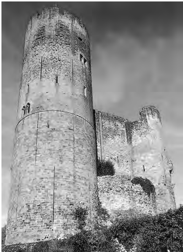
463. Najac (Aveyron), front oriental du château avec ses deux tours percées d'imposantes archères, vers 1253. Etat en 2000. (D. de Raemy)
