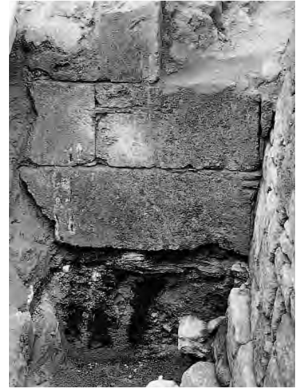
44. Yverdon, parement extérieur du mur de ville venant s'appuyer contre la tour ouest du château (à droite). Un moyen appareil de calcaire bien taillé forme le parement. Comme cela était le cas pour le château, le mur repose sur un radier formé de poutres de chêne, lui-même soutenu par des pieux enfoncés dans le sol meuble de sables et de graviers. Ces bois ont été datés par dendrochronologie des environs de 1366. Cela témoigne d'une reconstruction du mur de ville dans ce secteur certainement. Une nouvelle réfection importante interviendra en 1605–1607. Un pieu retrouvé à l'avant de ce parement a été abattu après 1252 et serait un témoin de la construction de l'enceinte primitive. Etat en 1988. (Fibbi-Aeppli, LRD88/R2164)
