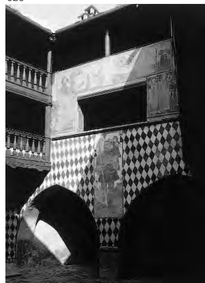
625. Château de Fénis (Val d'Aoste). Cour intérieure vue en direction de l'entrée. Etat en 1991. Portique et galeries-hautes maçonnées. À l'arrière, les planchers en bois s'étendent jusqu'à la courtine d'entrée. Le niveau du rez-de-chaussée se définit comme une sorte de vaste vestibule, un peu comme celui du château d'Yverdon situé entre la cour d'entrée et la cour intérieure. Le château d'Oron a présenté également un vaste couvert, non pas du côté de l'entrée (où il se trouve maintenant), mais à l'opposé, à l'emplacement du « réduit seigneurial ». Il était surmonté d'une galerie haute. Le portique de poteaux que l'on imagine à Oron a ensuite été fermé par une façade maçonnée en 1731. (D. de Raemy)
