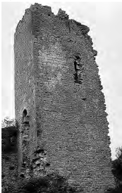
129. «Donjon» de Jasseron (Ain), grande (?) tour, vers 1250, édifée sous les seigneurs de Coligny. Etat en 2002. (D. de Raemy)
