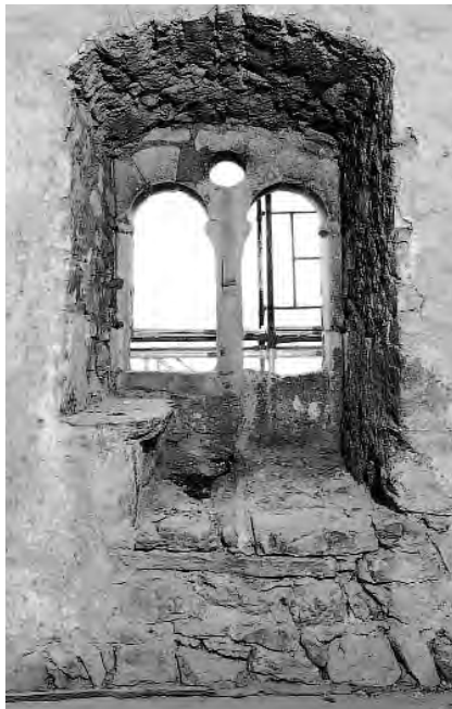
212. Château de Glérolles, baie géminée éclairant l'étage d'entrée de la grande tour, de 1248 environ, avec son coussiège et son système de verrouillage des volets intérieurs, Etat en 1995. (Fibbi-Aeppli)
