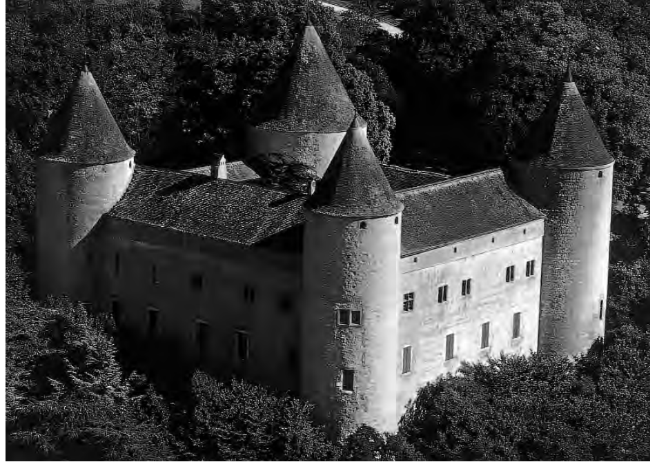
278. Château de Champvent, vers 1295–1300, vue aérienne depuis le sud. Etat avant 1981. Si le château paraît noyé dans les taillis aujourd'hui, il en allait tout à fait différemment au Moyen Âge. Il était en effet accompagné de son bourg situé au nord-est et la colline sur laquelle il est construit était dépourvue d'arbres pour laisser les abords dégagés; dès les origines sans doute, cette colline était plantée de vignes, bien attestées jusqu'à la fin du XIXe siècle encore. (Laslo Irmes)
