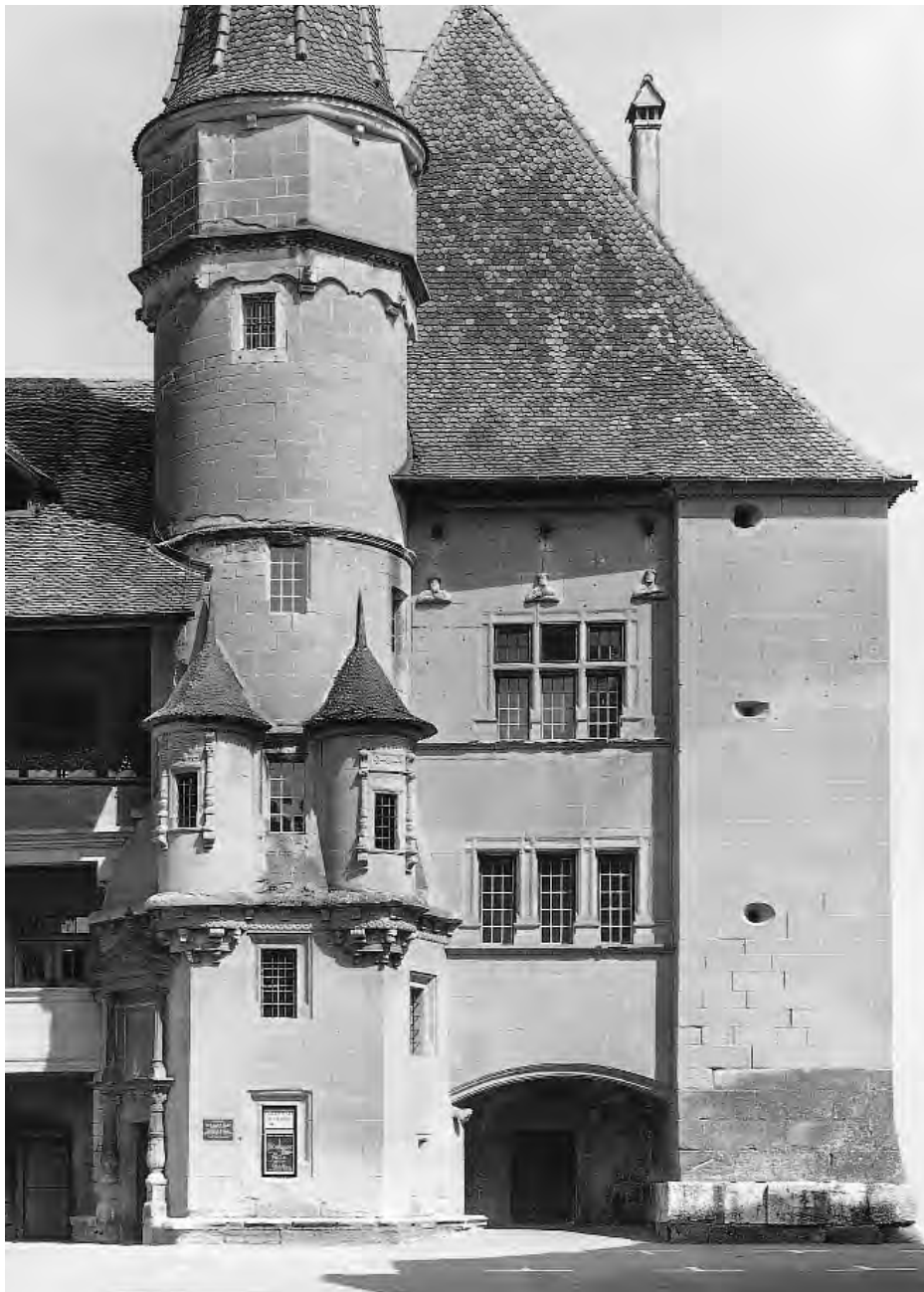
774. Château d'Avenches, vue vers le nord. Etat en 1995. Tour d'escalier, façade de la galerie et latrines plaquées entre 1565 et 1568 contre la grande tour quadrangulaire du XIV e siècle. (Cl. Bornand)
