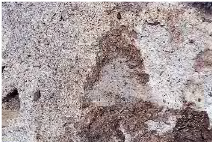
714. Fragment d'enduit projeté sur le couronnement de la grande tour. Si l'on fait abstraction de la crasse, visible au centre de cette prise de vue, on se rend compte que ce crépi était très blanc. La chaux était mélangée à un sable fait de petits graviers noir et ocre. Etat en 1999. (D. de Raemy)
