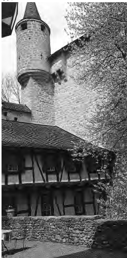
304. Château de Lucens, vers 1280. Tourelle nord en encorbellement commandant l'entrée au réduit seigneurial, vue depuis la cour du plain-château. Etat en 1985. On voit encore une bretèche défensive qui protégeait cet accès, maintenant condamné. (D. de Raemy)
