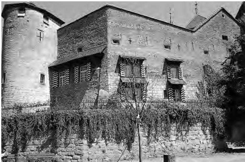
394. Château de Morat, courtine sud-ouest flanquée de la tour secondaire ouest. L'appareil original de l'enceinte de 1238, en petits boulets de rivière, est bien visible sous les fenêtres tout près de la tour. Observer encore les restes des baies-crèneaux, alternant avec des merlons, dont un sur deux est percé d'une petite fente de guet et de tir en croix, système des années 1290 ou du début du XIV e siècle. Au premier plan, la partie basse du mur de braies, soutenant les lices-terrasses, en bel appareil de grès coquillier du Vully. Etat en 1998. (D. de Raemy)
