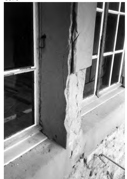
1076. Meneau en molasse d'une des baies de 1883 éclairant le second étage. (M. DuPasquier)
