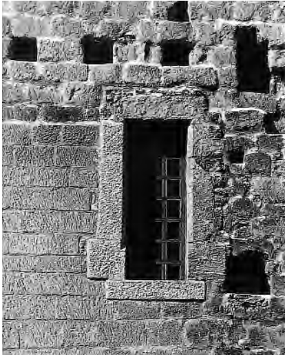
980. Château d'Yverdon, détail de la courtine sud, porte donnant dans la galerie d'acheminement des céréales. Etat en 1966, après sa restauration. Le linteau et le montant droit sont originaux, en grès de La Molière. La tablette et le montant gauche ont été restitués par Pierre Margot. Si la porte originale ne remonte pas à 1536–1539, elle pourrait être attribuée au bailli Frantz Güder (1607–1613), dont les armoiries, très abîmées, ont été retrouvées sur le linteau et fautiveusement interprétées comme celles de Vaucher de Dizy, châtelain à Yverdon en 1311 sous Louis II de Savoie. Constructivement, cet encadrement est comparable à ceux apparus dans le château au cours du XVIIe siècle jusque dans les années 1670. (P. Margot)
