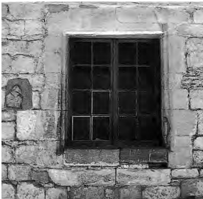
604. Château d'Yverdon, mur séparant l'aile nord de la partie nord de l'aile ouest, rez-de-chaussée (entre [109-1] et [110]). Restes de la grande porte reliant l'extrémité nord de l' aula au corps de logis nord de la grande cuisine. Etat en 1997. (Fibbi-Aeppli)
