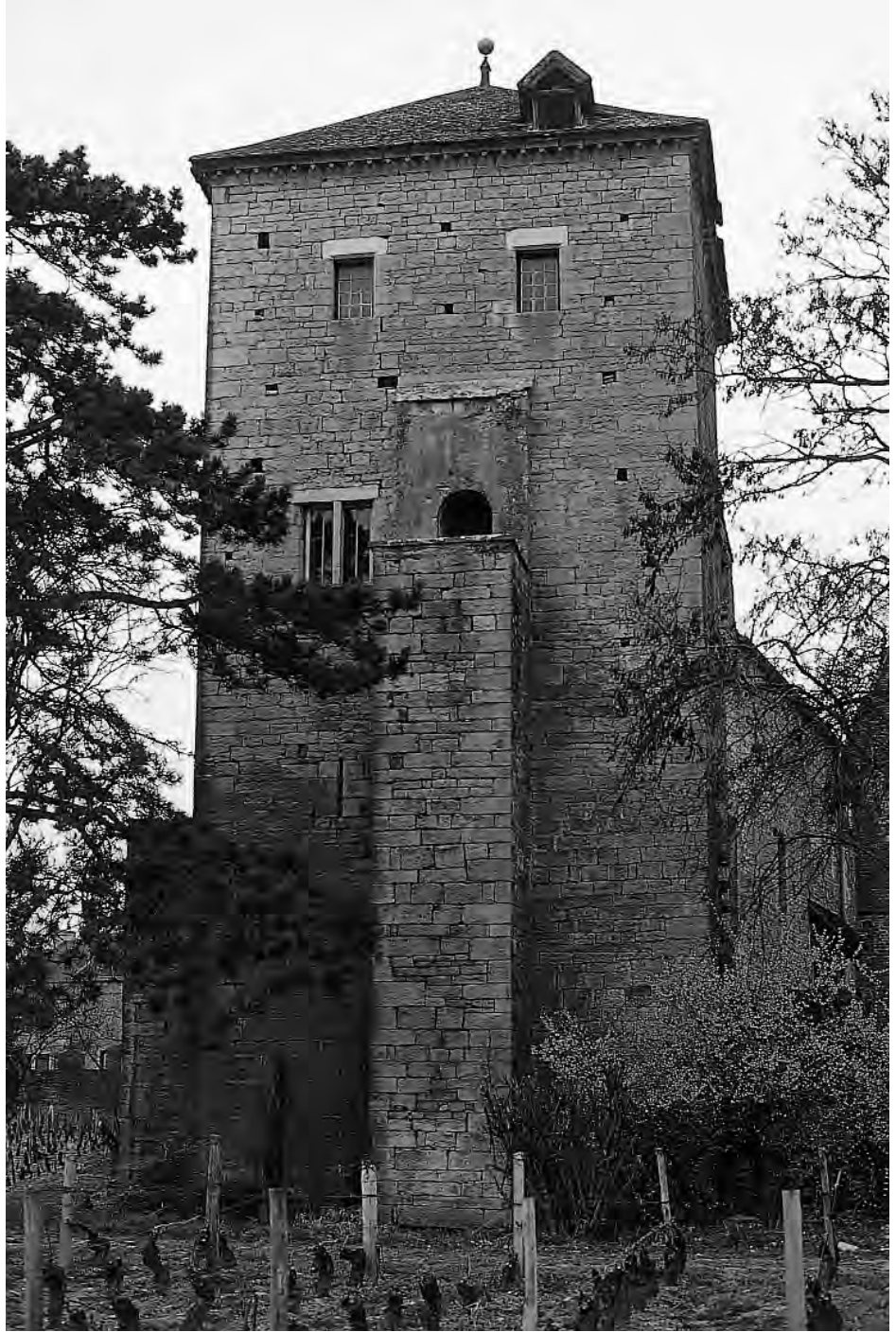
562. La tour de l'ancien prieuré de Gevrey (Gevrey-Chambertin, Côte-d'Or), dépendant de Cluny, édiflée vers les années 1270, apparaît comme une réduction de la Tour du Moulin (MOUILLEBOUCHE 2002, p. 215), avec baies-crè-neaux à coussiège au niveau du chemin de ronde. Les deux faces de la tour donnant à l'extérieur sont équipées chacune de latrines installées à mi-hauteur de la tour, au niveau de l'étage d'entrée, sur un ouvrage saillant de plan quadrangulaire, contenant le canal d'évacuation (il ne s'agit pas d'escaliers en vis comme le prétend LE HALLE 1990, p. 136). À la différence de la tour du Moulin qui n'en a pas (il s'agit plutôt de fenêtres étroites), cette tour est dotée également de vraies archères à niche (l'une d'elles est visible à gauche), ce qui en accrédi-terait, peut-être, la construction plus tardive. Etat en 2003. (D. de Raemy)
