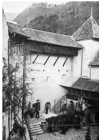
798. Château de Chillon. Mur nord de l'ancienne tour L, percé de meurtrières défensives couvrant la cour d'entrée D. (ACHC, A4, 23ter)
