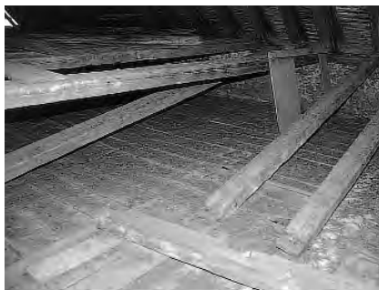
617. Château de Vuissens, combles du grand corps de logis oriental, vers 1530. Les tirants de la charpente se situent environ 80 cm au-dessus du plafond des salles, couvert de terres cuites. Etat en 1995. (D. de Raemy)
