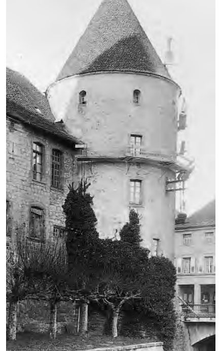
964. Château d'Yverdon, courtine orientale et tour des gardes. Décrépissage de cette dernière commencé à la fin de l'année 1918. Le parti d'orner les murailles de végétation grimpante est apparu au début du siècle. Cette dernière s'est déjà largement déployée depuis les travaux de 1903-1906. Il faut observer la précarité des échafaudages, sur lesquels osaient se lancer les ouvriers. (AFMH)
