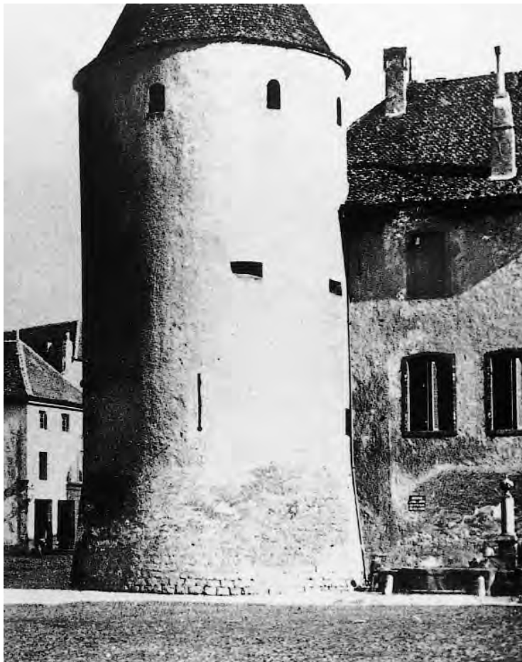
1009. Château d'Yverdon, tour nord «de la Place» et amorce de la courtine occidentale. Cette vue est antérieure à 1877 puisque la seconde fenêtre du laboratoire n'y figure pas encore. La lumière rasante met en évidence la texture légèrement granuleuse de l'épais enduit qui recouvrait alors les murailles du château. Cet enduit, dans la partie éclairée en tout cas, est postérieur à 1715, année où le parement de la tour est intégralement refait en tuf sur cette portion. (MY, André Schmid?)
