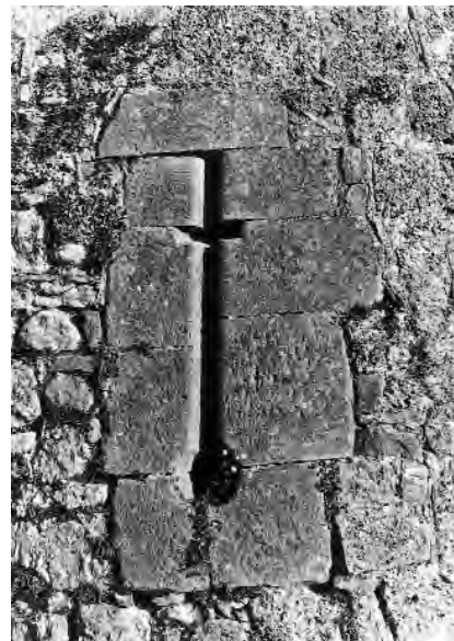
752. Château de Grandson, tour hémicirculaire sud-ouest. Meurtrière en croix et à trou de serrure de l'époque Chalon (vers 1473–1475), ayant remplacé une archère, percée dans les parties basses de la tour et permettant le tir horizontal sur la lice-terrasse dominant le bourg de Grandson. Etat en 1985. (D. de Raemy)
