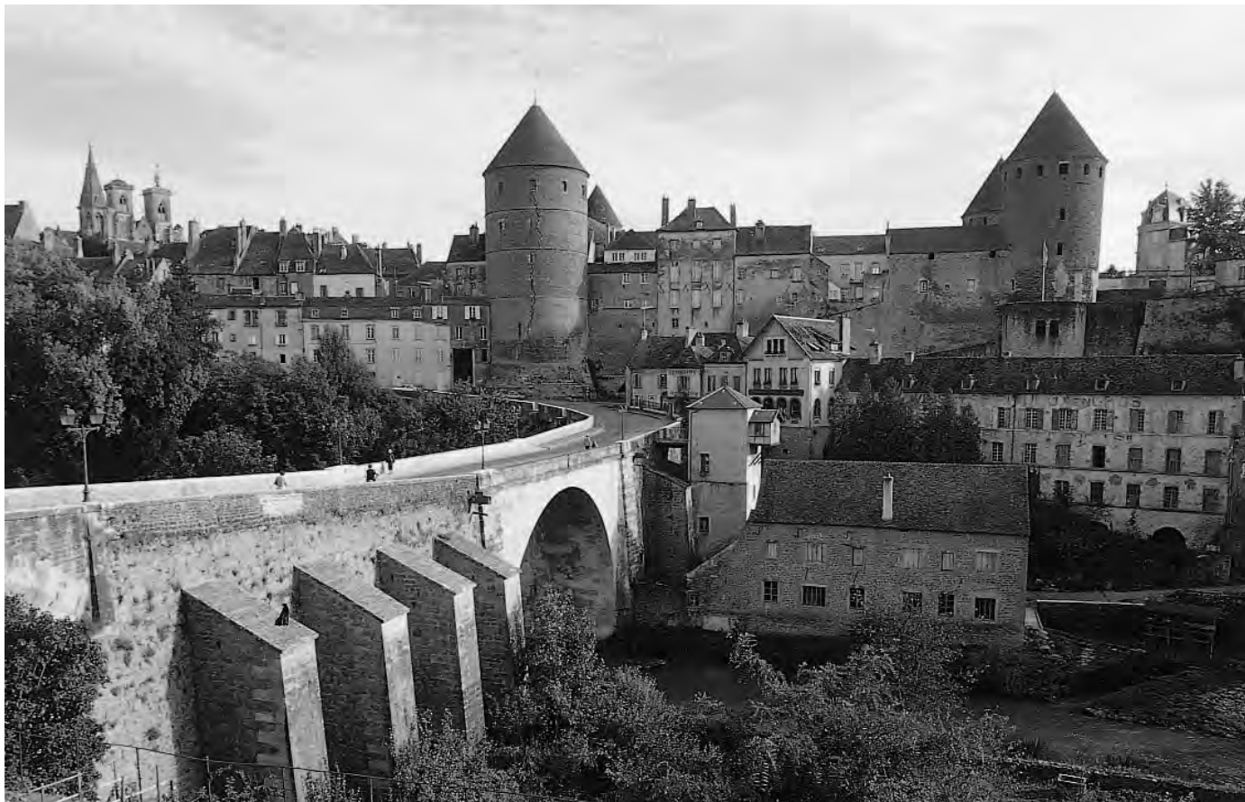
527. « Donjon » de Semur-en-Auxois (Côte-d'Or), après 1276? Vue de l'ouest. Le « donjon » domine l'Armançon et commande l'entrée en ville de ce côté. Indéniablement, la silhouette générale du « donjon » rappelle, en plus grand, le château d'Yverdon. Les courtines et les corps de logis qui s'y appuyaient ont largement disparu dès le démantèlement ordonné par Henri IV au début du XVII e siècle. Tout à gauche, la collégiale Notre-Dame, édifiée dans le bourg dès 1218–1220. Etat en 1995. (D. de Raemy)
