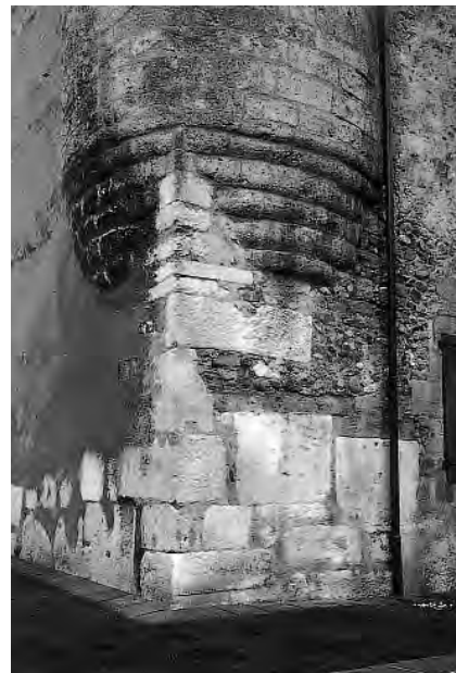
787. Château de Nyon, encorbellement à ressauts toriques de la fin du XIIIe siècle (1293?) de la tourelle nord-ouest (elle, réédifiée à la période bernoise), placée sur une chaîne d'angle formée de gros blocs de calcaire en réemploi provenant de la ville romaine. Etat en 1995. Cette base est la seule originale; les tourelles côté lac ont été complètement reconstruites – sans doute enveloppées – lors des travaux de 1574–1583, devenant de vraies tours prenant leur appui dans le sol. (D. de Raemy)
