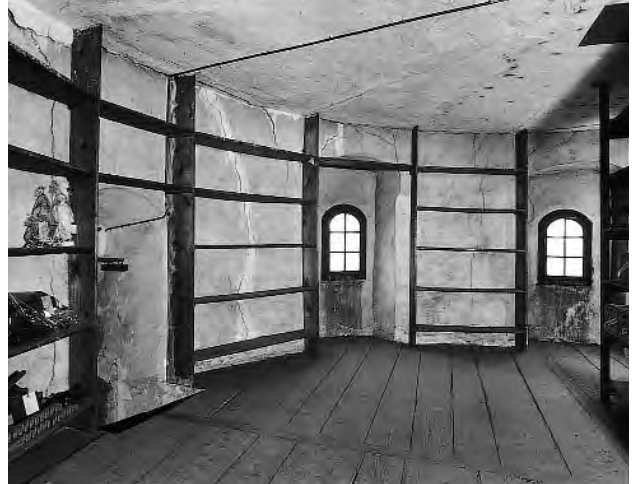
895. Château d'Yverdon, tour orientale, étage du couronnement, vue vers le sud. Etat en 1993. Le plafond en plâtre, l'enduit des parois, les châssis de fenêtre sur les jours de l'époque bernoise et le plancher à frises de chêne ont été posés en 1809 pour le cabinet de sciences naturelles de Pestalozzi déplacé en 1816 dans la tour des Juifs. Le plafond a été enlevé en 1994 afin de laisser visible la charpente de 1489. (Fibbi-Aeppli)
