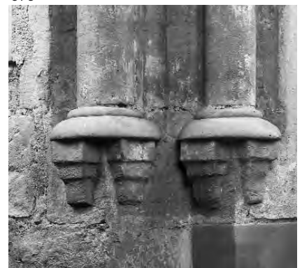
579. Château d'Yverdon, grande baie de la chapelle, détail montrant les bases toriques sur denticules à ressauts des colonnettes engagées ornant les montants de la baie. Etat en 1997. (SBC-VD, Fibbi-Aeppli)
