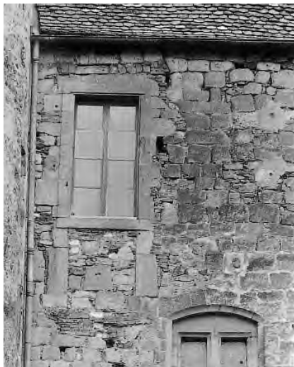
894. Château d'Yverdon, courtine sud, porte installée au plain-pied de l'étage permettant d'accéder aux latrines édifiées en 1806 pour remplacer celles qui avaient été supprimées contre la courtine ouest. La transformation en fenêtre simple interviendra à l'époque des écoles publiques, lorsque ces latrines seront supprimées (1839) et remplacées par celles construites dans la tour des Juifs ou dans l'épaisseur de la courtine sud. Etat en 1974. (P. Margot)
