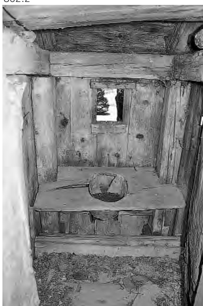
862.2. Château de Vuissens, habitacle charpenté des latrines accroché contre la courtine orientale. Etat en 2003. (D. de Raemy)
