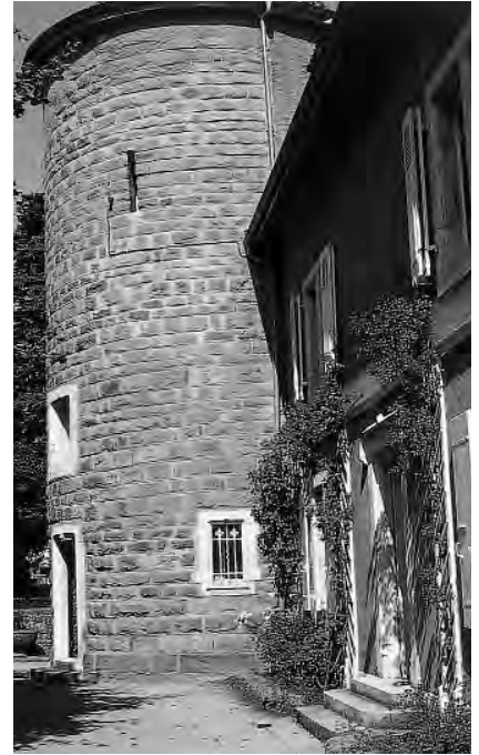
362. Château de Grilly, fin du XIIIe siècle, tour secondaire sud-ouest, vue du sud-est. La partie protégée des intempéries montre encore le moyen appareil original de molasse en bossage. Etat en 2002. (D. de Raemy)
