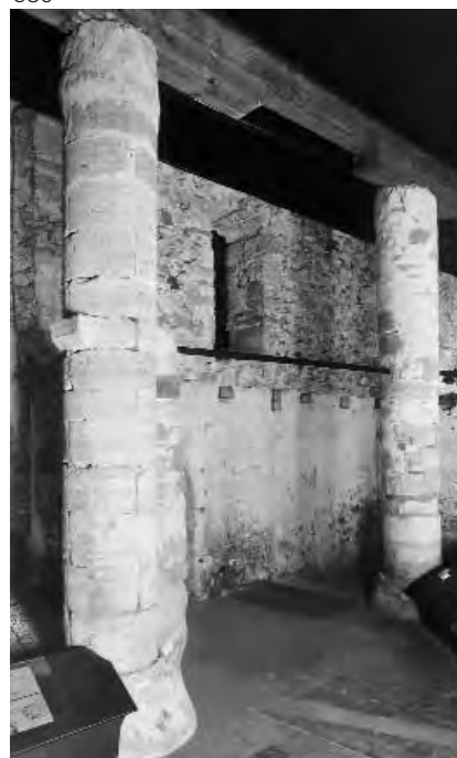
384. Château de Grandson, courtine orientale du « carré savoyard » ou du « grand château », selon Otto Schmid. Etat avant la restitution de l'aile de la stupa par cet architecte en 1913. 1. Celliers. 2. Salle de l'« artillerie » avec sa grande cheminée. 3. Camera domini , éclairée par une fenêtre en arc brisé et chauffée par une cheminée dont il reste la partie haute du manteau. 4. Grande stupa , chauffée par une vaste cheminée dont il reste les traces de la hotte et du piédroit droit. On observe encore les corbeaux ayant supporté le plafond, restitué par Schmid à ce niveau en 1913. 5. Chemin de ronde à ciel ouvert à l'origine. (ACV, AMH, R. Gindroz)
