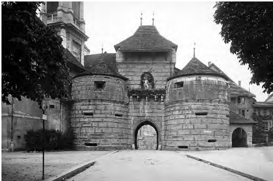
769. Soleure, enceinte orientale, la porte de Bâle dans le prolongement nord du chevet de l'ancienne collégiale Saint-Ours. Etat vers 1920. Le maître d'œuvre valsésien Jean Gibelin est chargé en 1502 et 1504 de l'édification de cette porte à deux tours d'artillerie, le tout pour une somme de 3000 livres environ. (AFMH)
