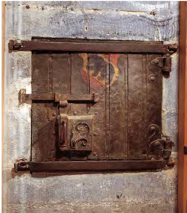
815. Château d'Oron, embrasure de la fenêtre sud-est éclairant la chambre du pont. Coffre mural de 1570 installé dans ce qui était la grosse Stuben . Etat en 2002. (R. Gindroz)
