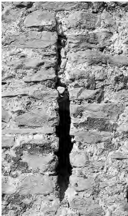
263. Château de Bonneville (Haute-Savoie), tour circulaire sud-est. Archère obturée de la partie basse. Etat en 2000. Toutes les archères originales du château de Bonneville sont de ce type, à encadrement de grès grossièrement équarri mais certainement recouvert d'un enduit plus couvrant à l'origine. À l'arrière, l'embrasure est visible mais obturée. Le jour mesure 1,55 m x 0,08 m. (D. de Raemy)
