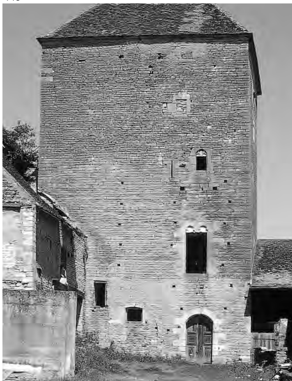
448. Vault-de-Lugny (Yonne). Tour quadrangulaire, couronnement doté de baies-créneaux simplement rectangulaires, et avec une latrine-bretèche. Etat en 2002 (D. de Raemy)
