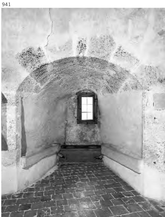
941. Château d'Yverdon, tour occidentale dite «des Juifs», 3 e niveau à la hauteur de l'étage des corps de logis adjacents. Dans l'embrasure de la fenêtre de 1605-1607 ont été aménagés en 1872 deux urinoirs allongés pour les élèves du collège. Etat en 1997. (Fibbi-Aeppli)
