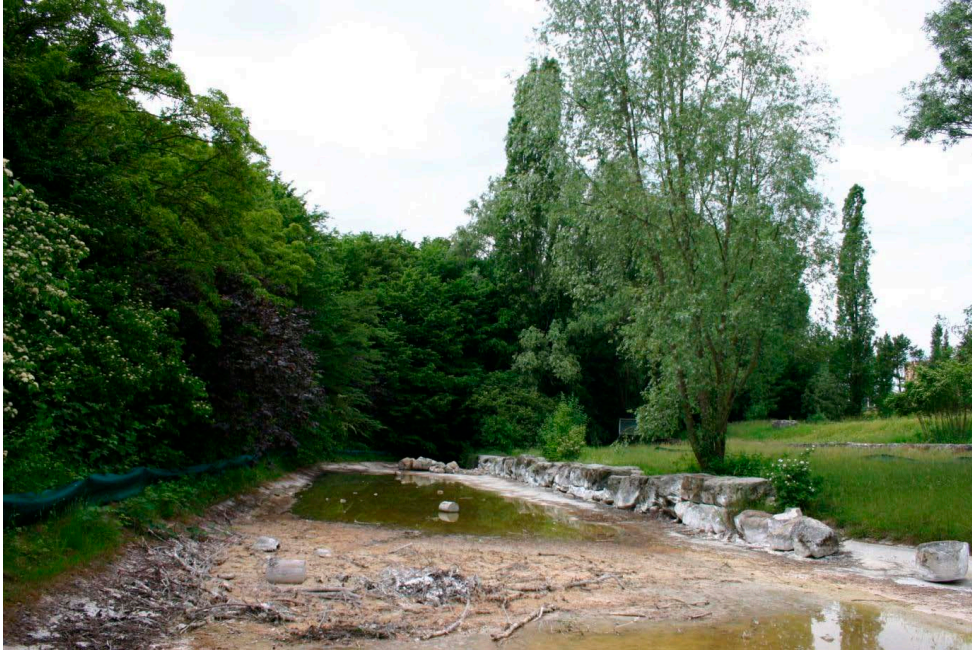
Figure 1.—Étang de Vidy en cours de vidange pendant les travaux de 2010. A gauche: barrière mise en place pour empêcher la migration des écrevisses, A droite: enrochements problématiques chaulés, puis bétonnés pour ne pas offrir de refuges aux écrevisses.
