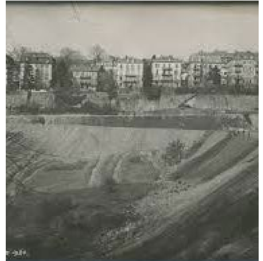
Construction du Pont Chaudron, 1924, La mémoire des images, BCUL-Musée Elysée
