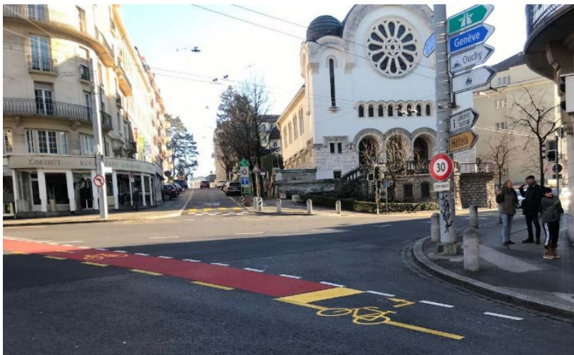
Fig. 3 Tourner-à-gauche indirect au carrefour av. Juste-Olivier – Rue Belle-Fontaine ; depuis av. Georgette vers av. Belle-Fontaine, Lausanne, Transitec, 2022.
