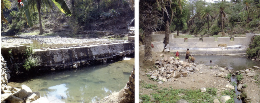
Figure 32. Rénovation de la structure de collecte des eaux « Bhutiya » dans le village de Amda, avant et après l'intervention
