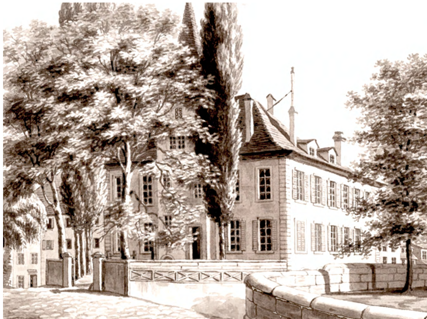
Figure 7 : pavage et aménagement de la place de la Cathédrale (1887) avec une nouvelle entrée à la maison Gaudard, mieux centrée et marches d'escalier (ACV).
