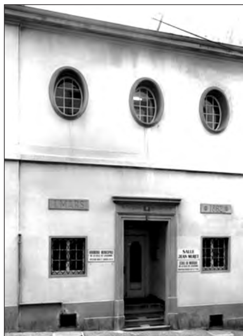
Figure 22. Façade du Musée Industriel, rue Chaucrau à Lausanne, avec l'entrée de l'auditoire où se donnent les séances de la Société Vaudoise des Sciences Naturelles de 1862 à 1905 (ACV).
