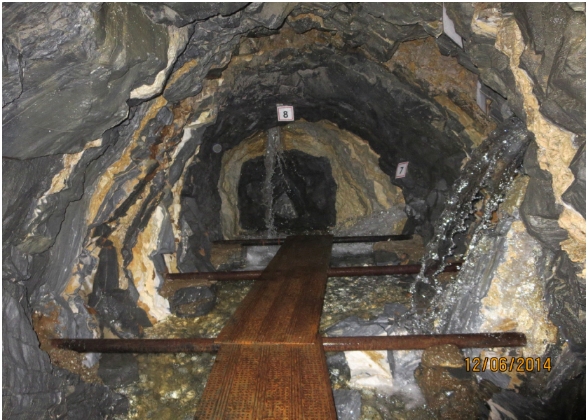
Fig. 12: Hauptquellfassung von Remo in karbonatischen Gesteinen der Canavese-Zone. Foto Municipio di Muralto, 2014.
