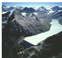
Barrage de la Gde Dixence
