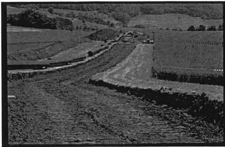
Abhumusieren bei Gasleitungsbau
